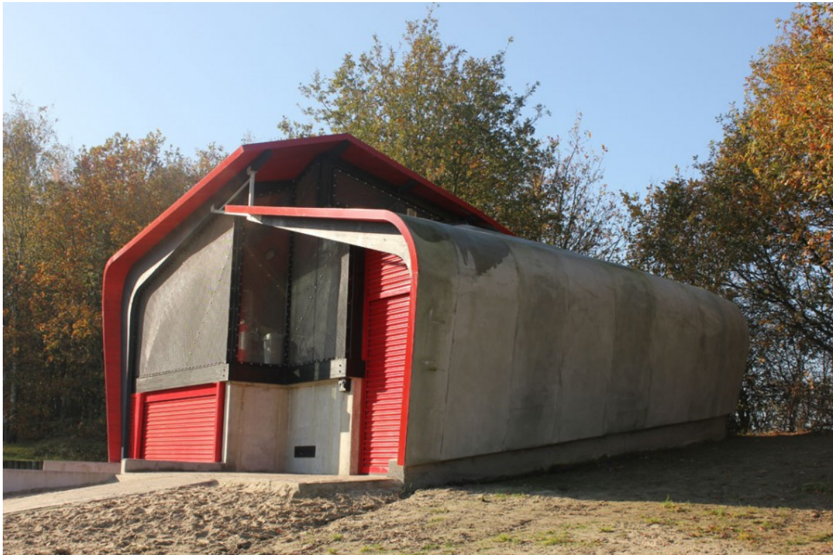
Abb. 123: Pavillon in Breda, NL: Eine Schicht „selbstheilender“ Bio-Beton soll auftretende Risse automatisch wieder verschließen. Architekt: Frank Markus Leeuwen. Quelle: http://www.marcus-architecten.nl/?p=180
