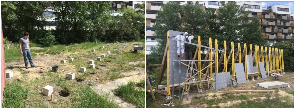
Abb. 29: Links: Beginn der Fundamentarbeiten. Rechts: Beplankung mit Rigips Habito GK-Platten (eigene Darstellung)
