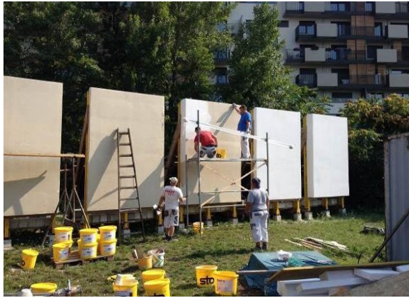
Abb. 32: Links: Armierungsbeschichtung Rechts: Beschichtung mit weißem, mitteldickem Putz (eigene Darstellung)
