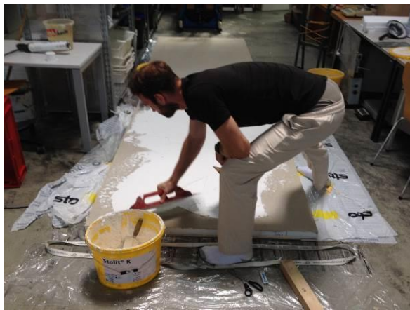
Abb. 51: Links: Beschichtung mit Armierungsschicht Rechts: Beschichtung mit Deckputzschicht (eigene Darstellung)
