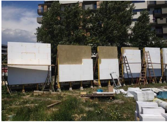
Abb. 31: Links: Die erste Dämmstoffplatte Rechts: Montage des Dämmstoffs 8 und 24 cm stark (eigene Darstellung)
