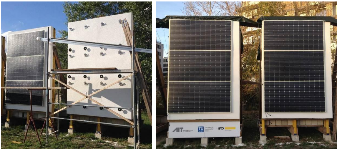
Abb. 42: Die montierten Befestigungselemente (links) und die montierten DAS-Energy-Module (rechts) (eigene Darstellung)
