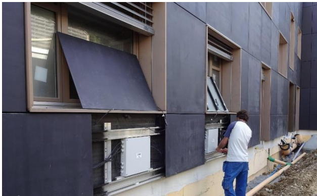
Abb. 21: Montage der PV-Paneele am autarken MFH Brütten [17]
