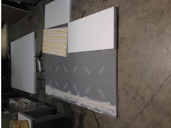
Abb. 50: Links: Aufkleben von Dämmstoff auf Tragplatten Rechts: Komplette Lage mit 4 cm Dämmstoff (eigene Darstellung)
