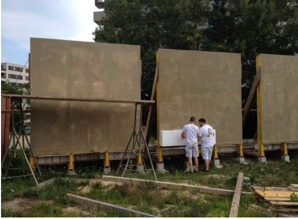
Abb. 31: Links: Die erste Dämmstoffplatte Rechts: Montage des Dämmstoffs 8 und 24 cm stark (eigene Darstellung)
