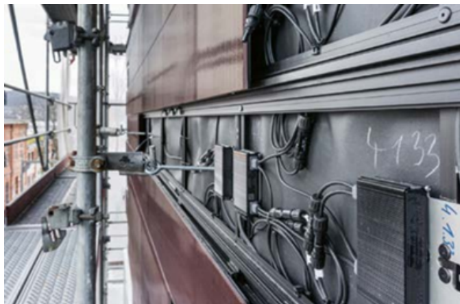
Abb. 18: Links: Konstruktionsschnitt der PV-Paneele WH Solaris. Rechts: Darstellung der Befestigung der PV-Paneele WH Solaris. [15]
