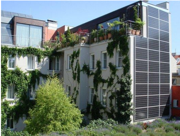
Abb. 23: PV an der „Feuermauer“ des Boutiquehotels-Stadthalle in Wien [19]
