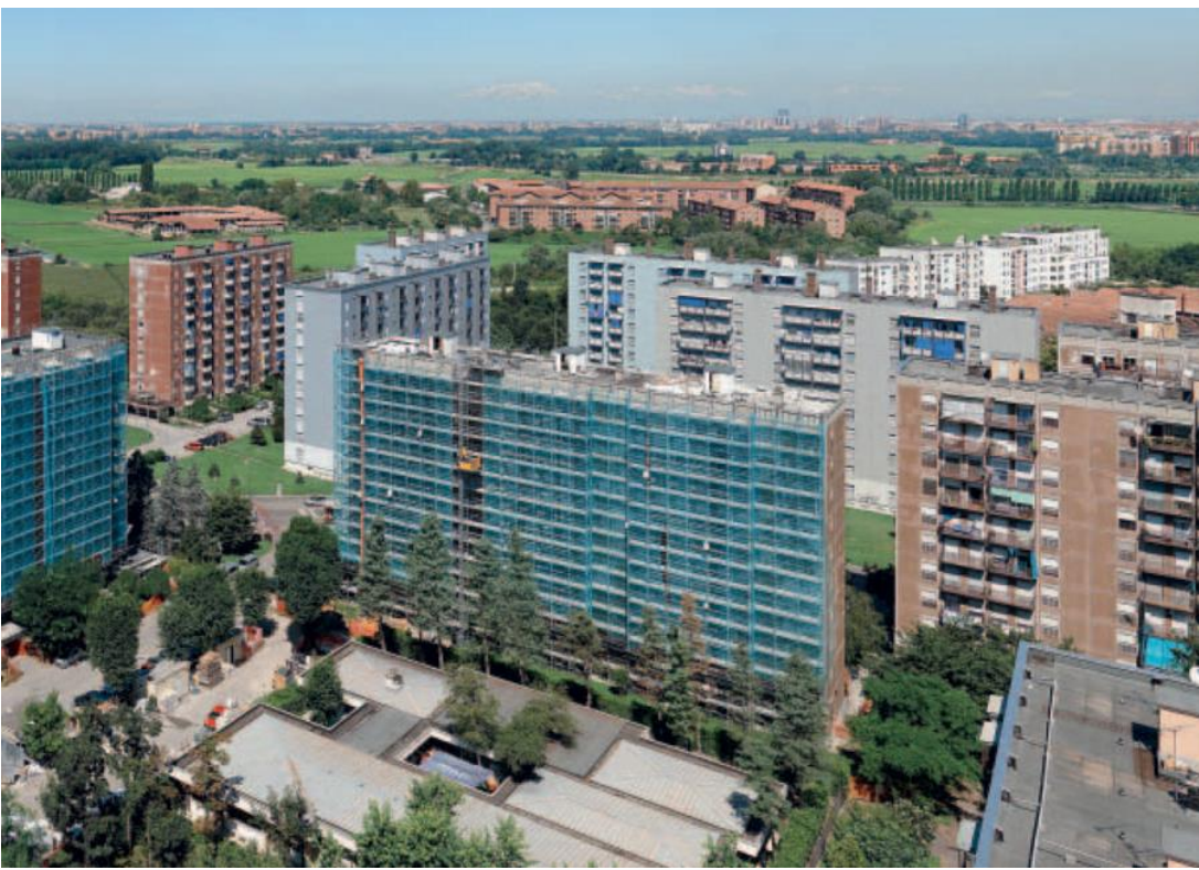
Die Wohngebäude von Gratosoglio während der Fassadenrenovierung Source: Arketipo
