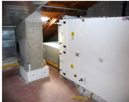
Zentrale Lüftungsverteilung im Treppenhaus
