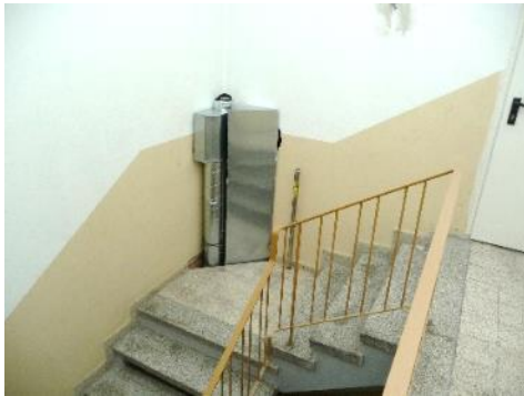
Zentrale Lüftungsverteilung im Treppenhaus
