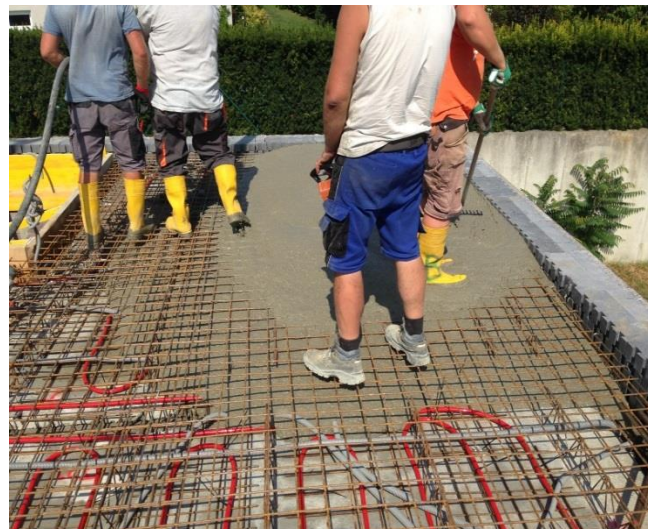
photo credits: Aichinger Hoch- und Tiefbau
