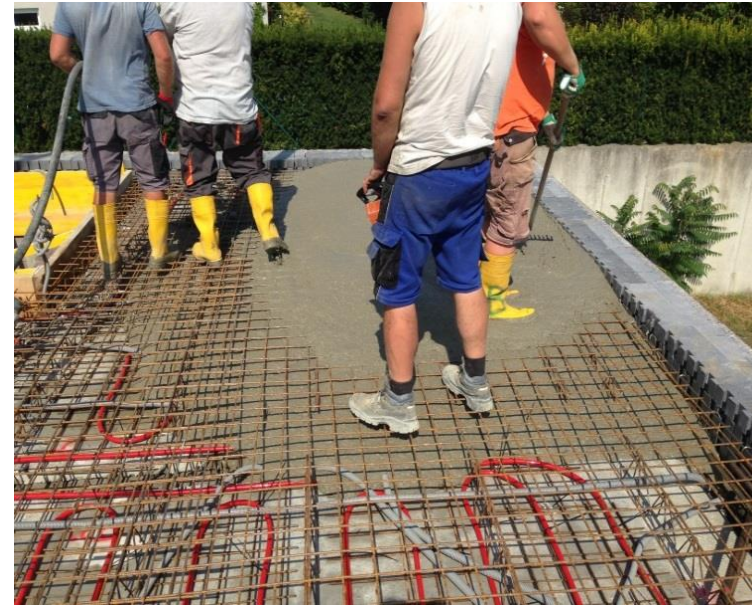
photo credits: Aichinger Hoch- und Tiefbau
