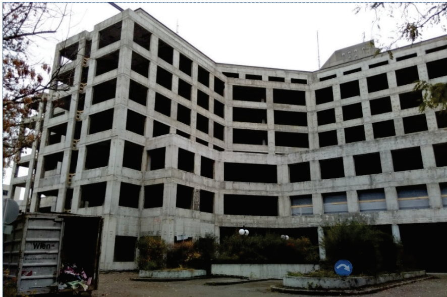
Abbildung 48: Stahlbetonkonstruktion des entkernten Bestandsgebäudes auf dem Areal des Franz-Josefs-Bahnhofs in Wien (Foto: Kleemann 2017)
