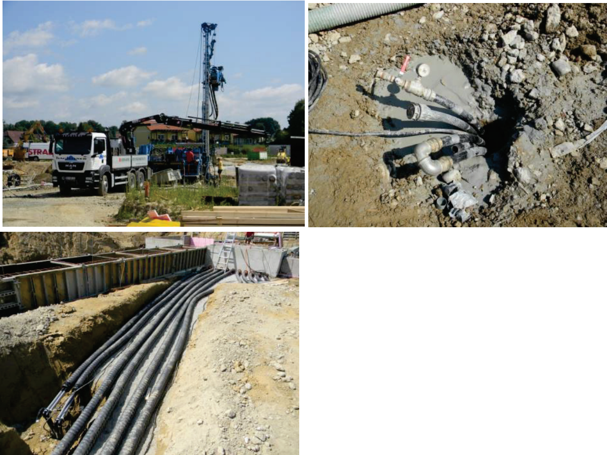
Abbildung 6 : Bau eines Erdwärmesondenfeldes (Fotos: G. Domberger)
