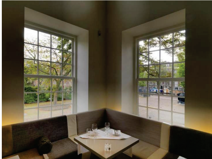
Abbildung 33 und 34: Eingebaute VG-Scheiben in Bestandsrahmen (Abbildung: NSG Pilkington Spacia).
