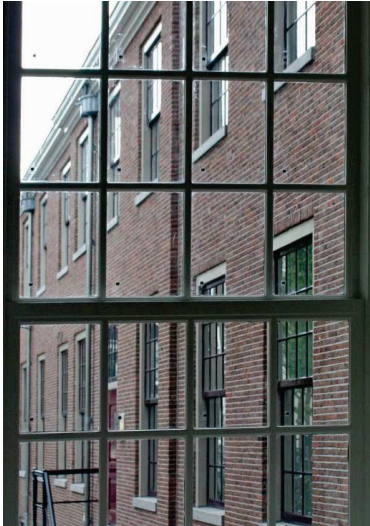
Abbildung 33 und 34: Eingebaute VG-Scheiben in Bestandsrahmen (Abbildung: NSG Pilkington Spacia).
