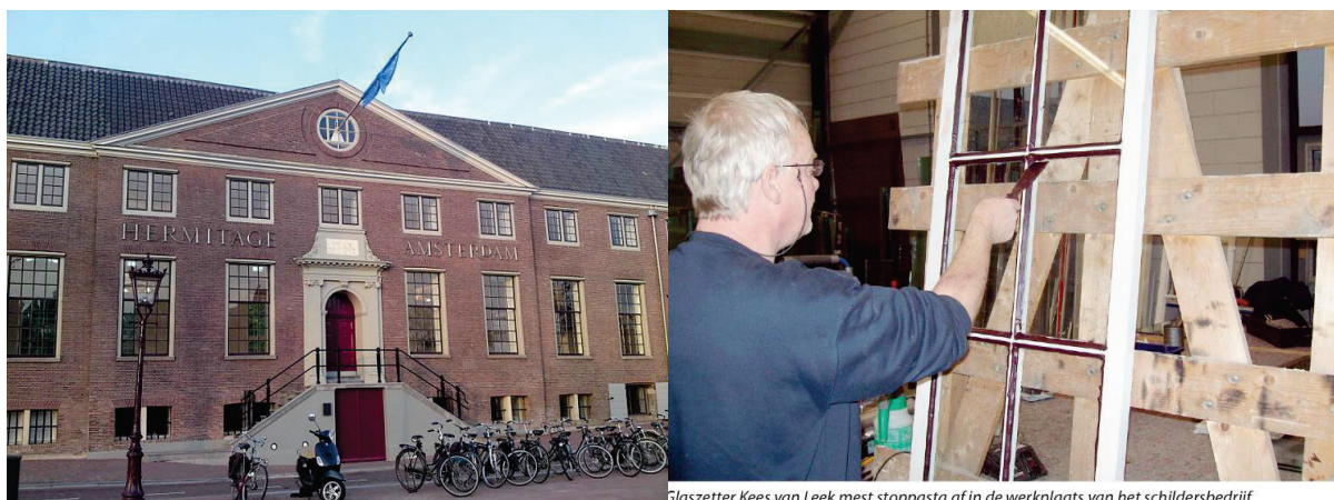
Glaszetter Kees van Leek mest stoppasta af in de werkplaats van het schildersbedrijf
