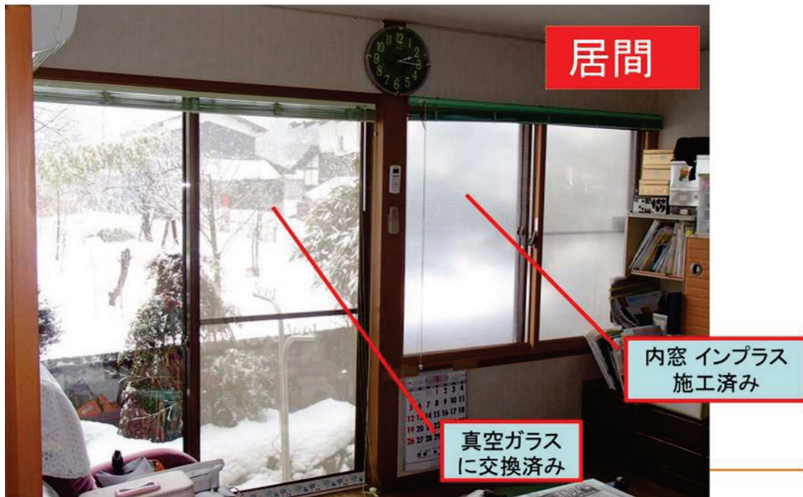
Abbildung 30: VG ohne Kondensat / Einfachscheibe mit Kondensat [ http://lixil-reformchain.jp/shop/SC00183004/case/016478.html ].
