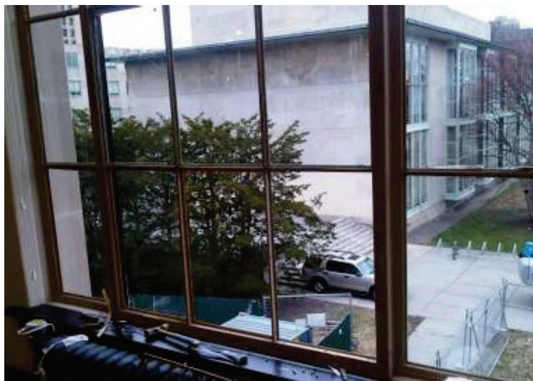
Abbildung 35, 36 und 37: Eingebaute VG-Scheiben in Bestandsrahmen (mit Ventil) (Abbildungen: www.brikbase.org/sites/default/files/best3_barry.pdf ).
