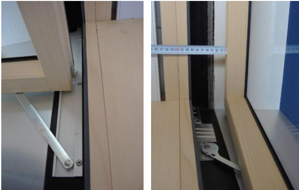
Abbildung 44: Links: Drehbeschlag; Rechts: Öffnungsbegrenzer
