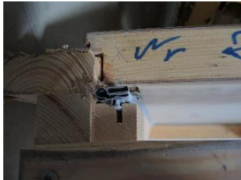
Abbildung 36: Links ist das geöffnete Türblatt mit einem Teil des Türstockes ersichtlich, der Metallstreifen im Türblatt ist an den zwei Längskanten und oben quer gut zu erkennen. Rechts oben: Beim Schließen der Tür finden sich Magnetdichtung und Metallstreifen. Rechts unten: Blick von unten auf Türstock und Türblatt mit komprimierter Magnetdichtung.
