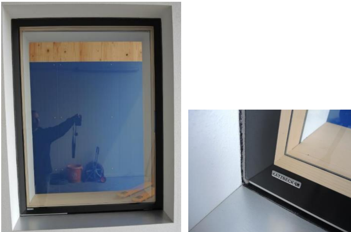
Abbildung 41: Außenansicht des nach außen öffnenden Fensters, in Ganzglasoptik
