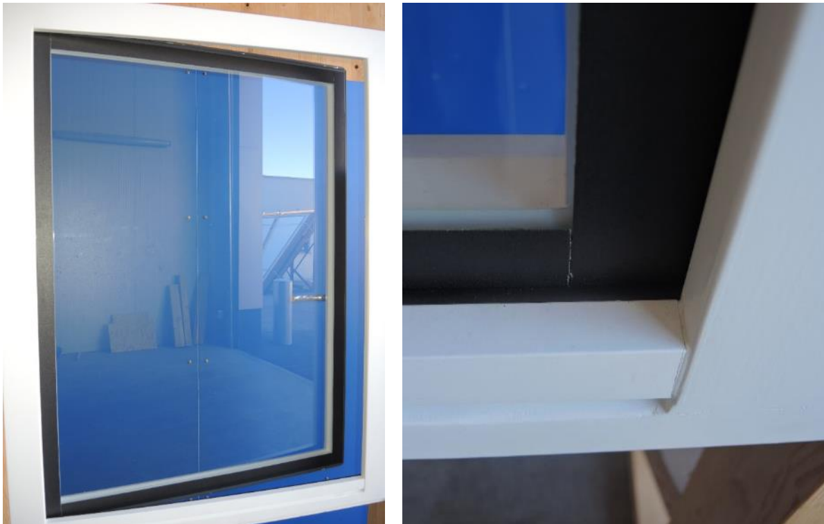
Abbildung 37: Außenansicht des Fensters, am Glas ist die schwarze Emallierung sichtbar.
