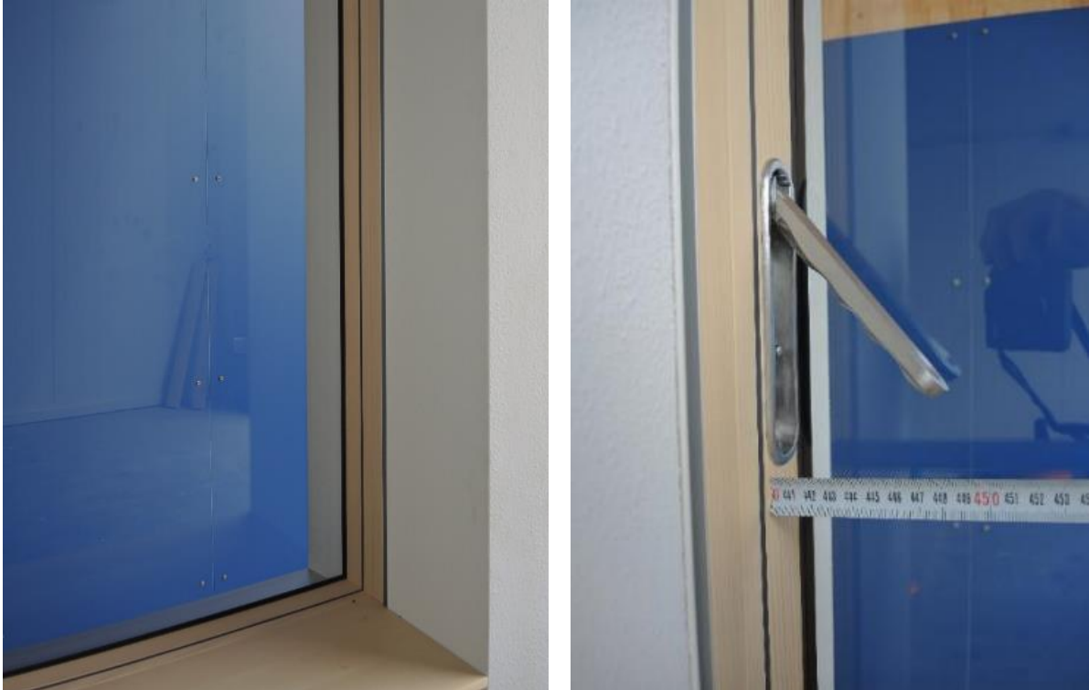
Abbildung 42: Innenansicht des Fensters bei dem die Lichte der Innenleibung jener der Stock-, Flügel- und Glaslichte entspricht und mit versenkbarer Griffolive
