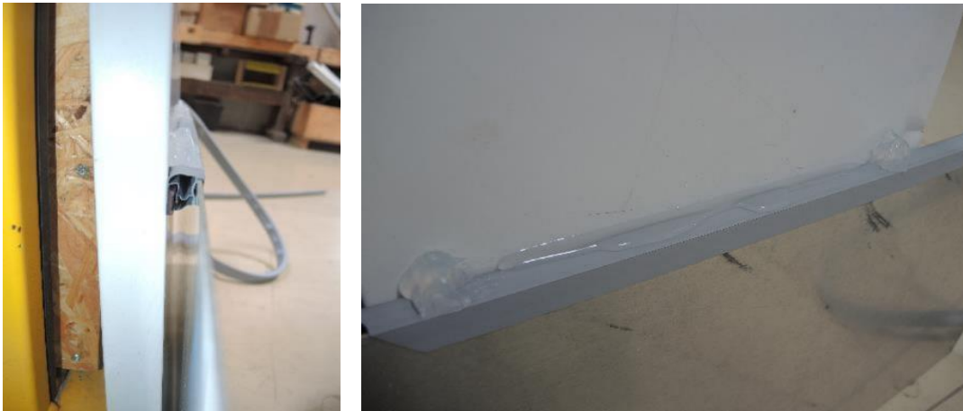
Abbildung 27: Links, auf einer Metalplatte applizierte Magnetdichtung. Rechts, der Anschlussbereich wurde mit Wasser gefüllt und über länger Zeit beobachtet.
