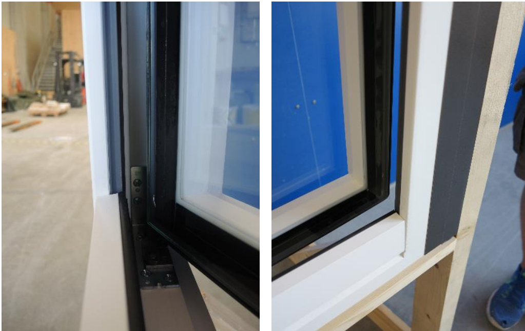
Abbildung 48: Außenansicht bei leicht geöffnetem Flügel. Der schwarze Glasrand wird bei geschlossenem Fenster vollständig vom Stock abgedeckt.
