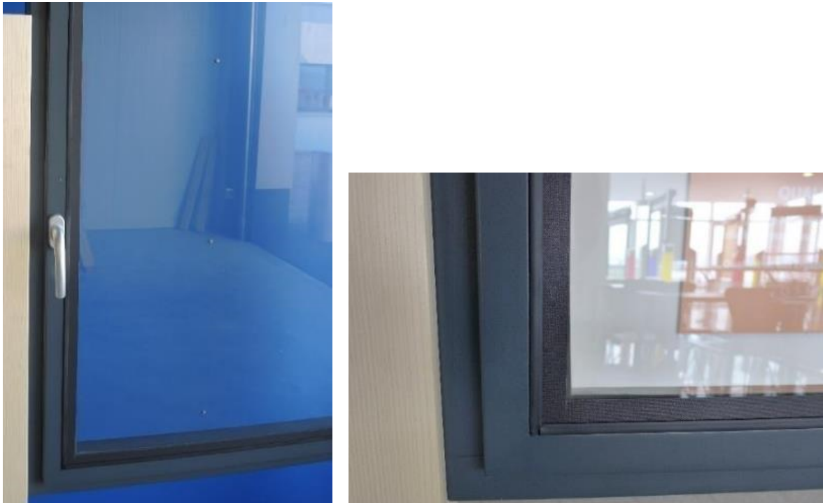
Abbildung 40: Innenansicht des Fensters, die Glasscheibe ist flächenbündig in den Flügel gesetzt
