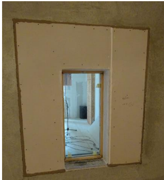
Abbildung 11: Hochschalldämmende Prüfwand in der Fensteröffnung mit eingebauter Scheibe
