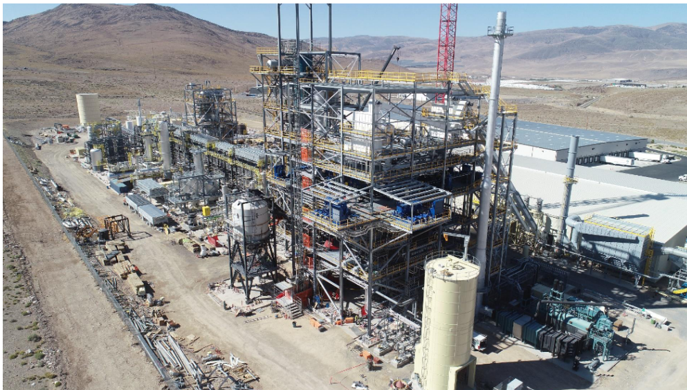
Abbildung 2: Die Konstruktion der Fulcrum Bioenergy/Sierra Biofuels Anlage
