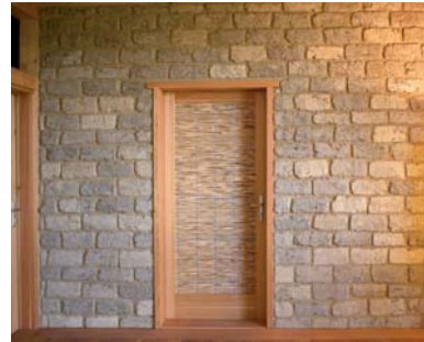
→ Mauer aus über 250 Jahre alten Lehmziegeln aus dem Abriss eines alten Lehmhauses in der Nachbarschaft.
