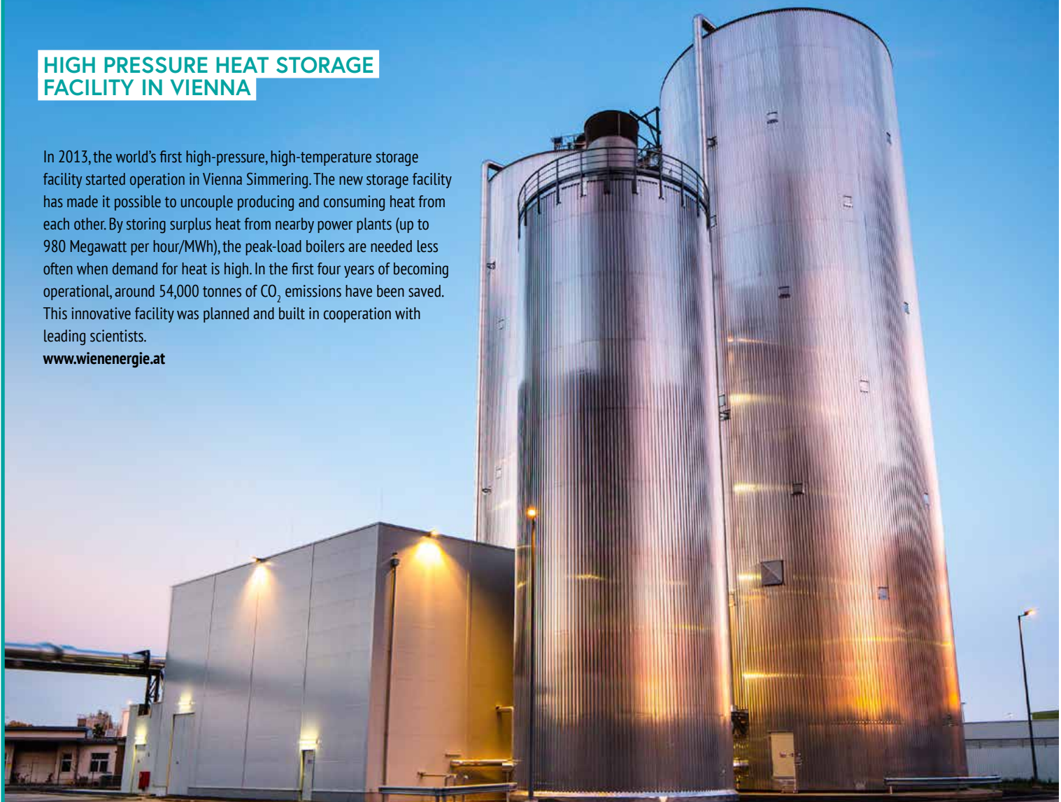
Photo: Wien Energie/Ian Ehm
