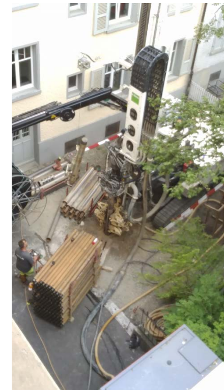
Alternative Erdsondenbohrung im Innenhof oder Öffentlichem Gut
