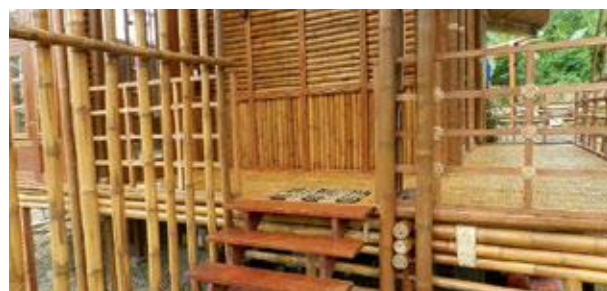
Zero Carbon Resorts, Demonstrationsgebäude, Foto: GrAT
