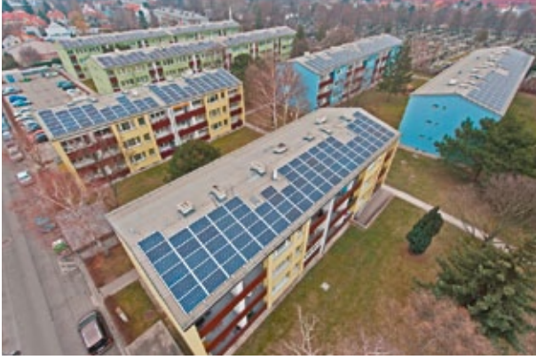
Die Stadt als Kraftwerk – PV-Anlage der Wien Süd in 1230 Wien, Foto: Wien Süd
