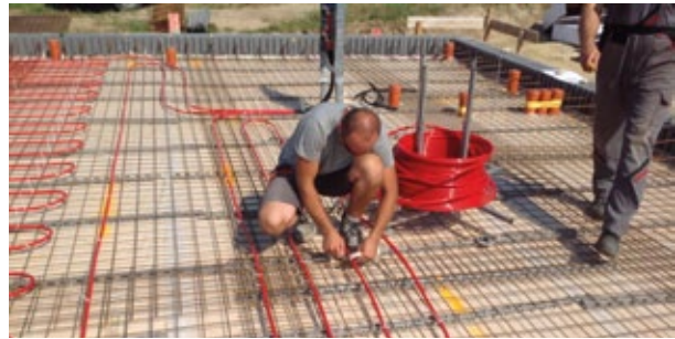
Belegung der zu aktivierenden Decke, Foto: Aichinger Hoch- u. Tiefbau GmbH
