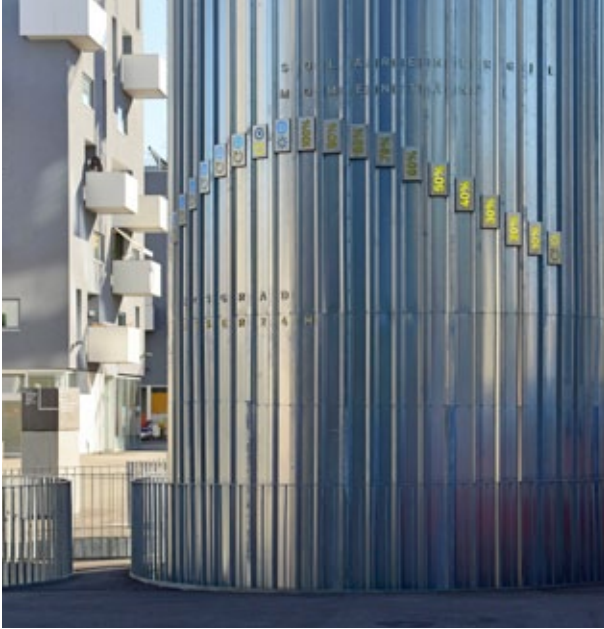
Solarspeicher, Foto: SIR
