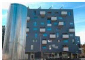
Stadtwerk Lehen - Solarspeicher, Foto: SIR
