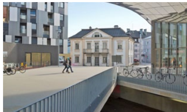
Stadtwerk Lehen, Salzburg, Foto: PRISMA
