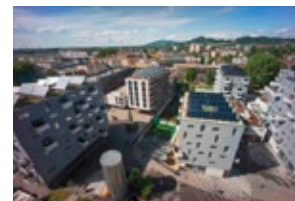
Stadtwerk Lehen, Foto: Stadt Salzburg
