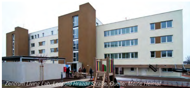
Zentrum Living Lab, Leopold Hrazdil Straße, Quelle: Meine Heimat
