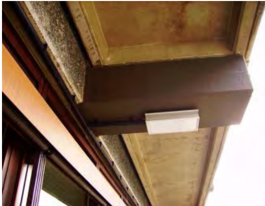
Wärmebrückenfreie Ausbildung war in den 60ern scheinbar noch unbekannt
