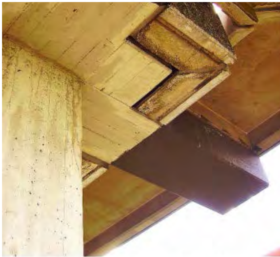
Eckausbildung der Fassade im EG
