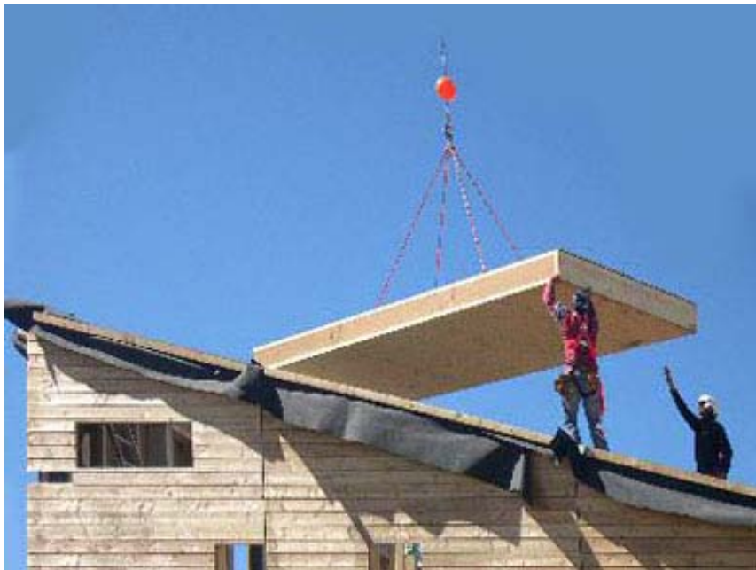
Abb. 35: Schiestlhaus: Montage der Dachelemente [Treberspurg & Partner Architekten, http://www.treberspurg.at , Abgerufen am 20.11.2007]
