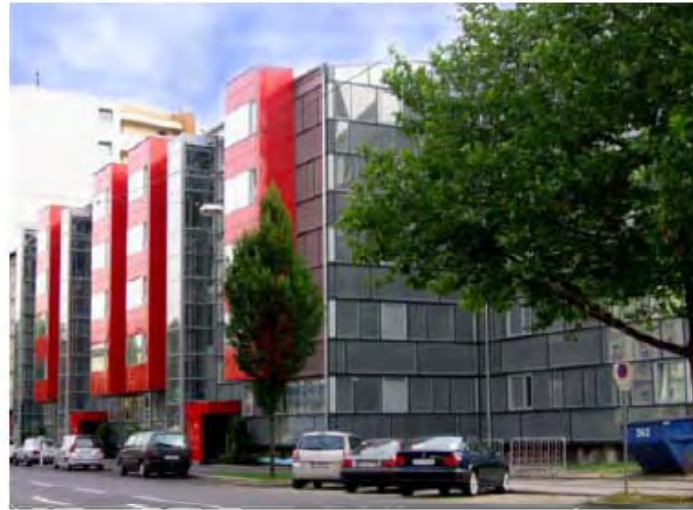
Abbildung 17: MFH Linz nach der Sanierung (GAP-Solution 2006, S. 1)
