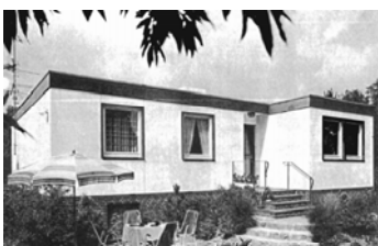
Typ 3: Bungalow mit Flachdach
