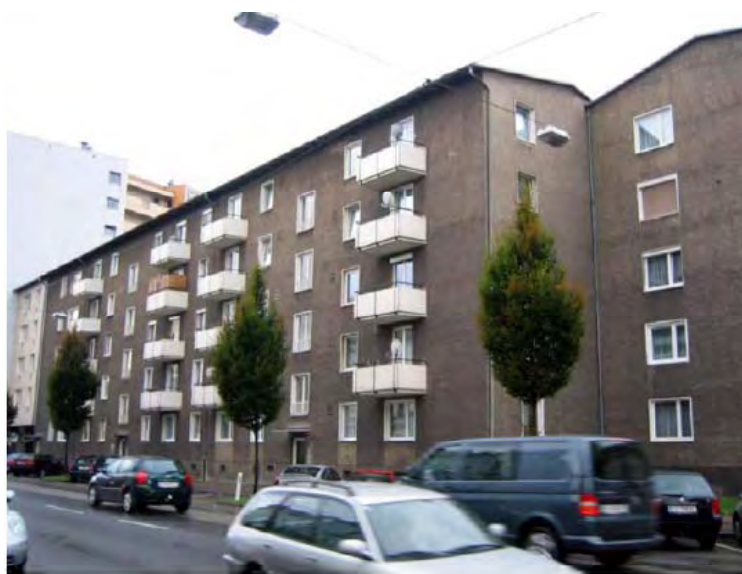
Abbildung 16: MFH Linz vor der Sanierung (GAP-Solution 2006, S. 2)
