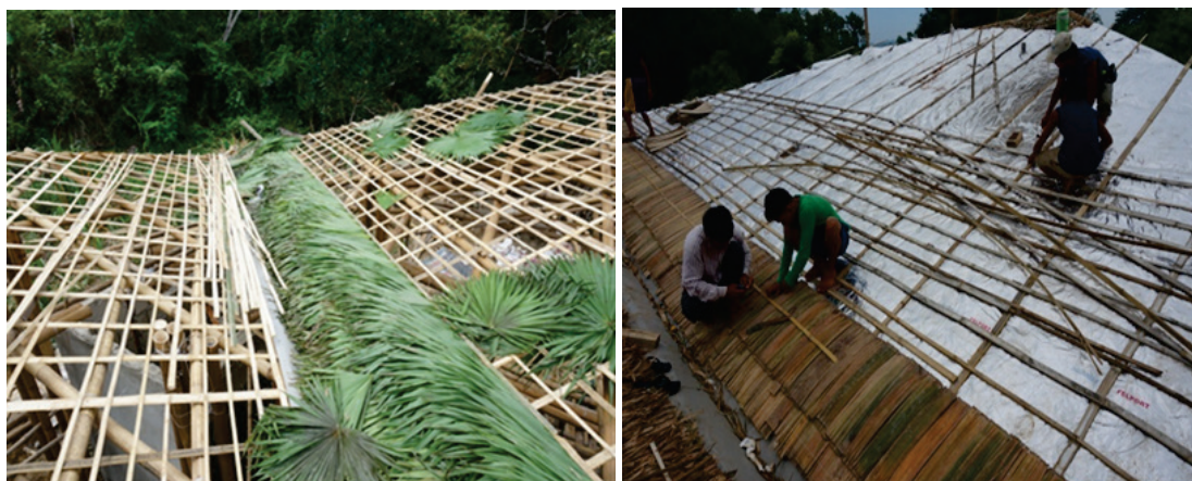
Abbildung 5: Neuartige Dachkonstruktion bestehend aus traditionellen und modernen Baumaterialien
