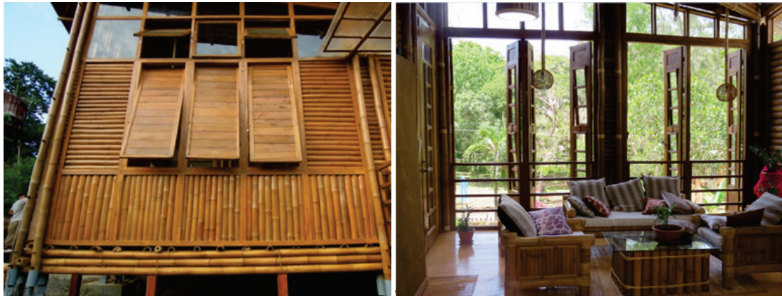
Abbildung 2: Fensterläden an der südwestlichen Gebäudeseite (links); große Öffnungen an der Ostseite (rechts)
