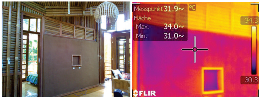
Abbildung 4: Stampflehmwand (links); thermografisches Bild niedrigerer Spitzentemperaturen (rechts)
