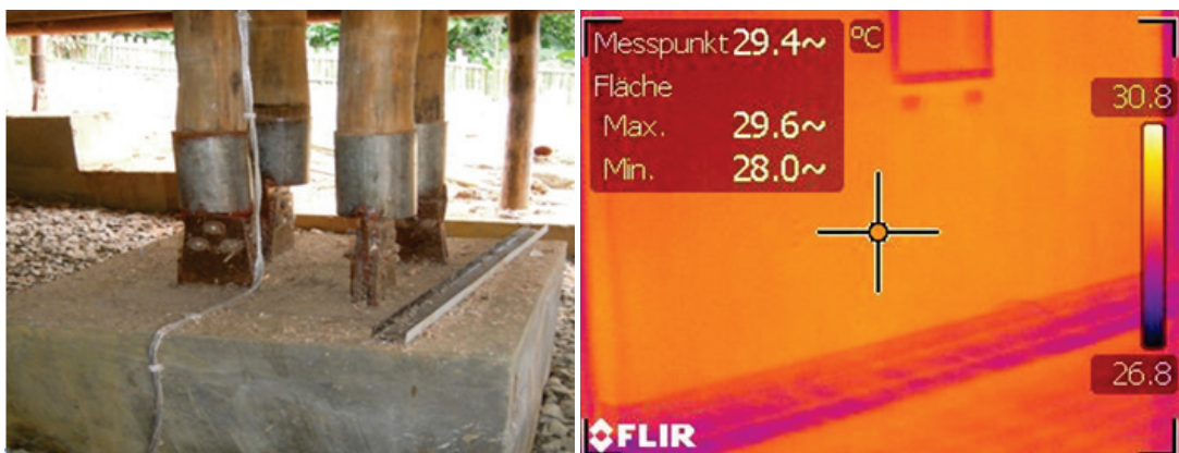
Abbildung 3: Punktfundamente mit Stahlverbindungen (links); thermografische Bild der Lüftungsschlitze (rechts)
