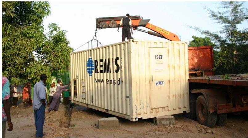
Abb. 2: Pilotanlage eines Photovoltaik-Diesel-Hybridsystems in Containerbauweise für die Versorgung eines Gesundheitszentrums in Gambia [3]
