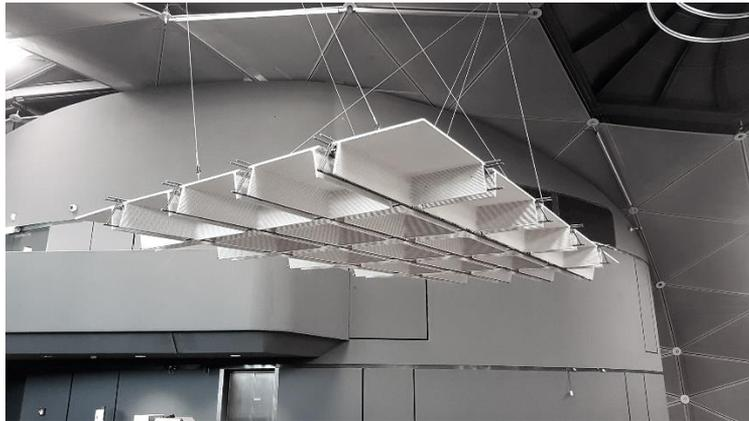
Abbildung 1: Modell einer Betonrippendecke mit 3D gedruckten Aussparungskörpern, Steiermarkschau 2021, Kunsthaus Graz, © Institut für Tragwerksentwurf
