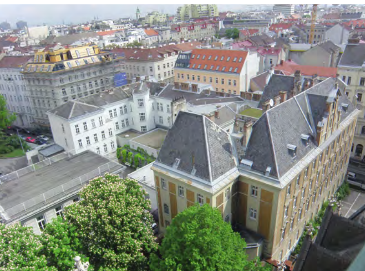
Kaiserstraße Wien, Quelle: Architekten Kronreif_Trimmel & Partner
