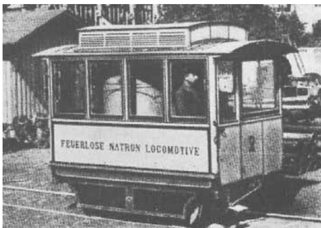
Abbildung 103: Mit Sorptionsspeicher betriebene Lokomotive der Aachener Straßenbahn.
