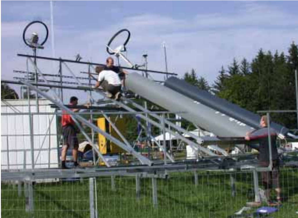
Abbildung 58: Montage der Kollektoren
