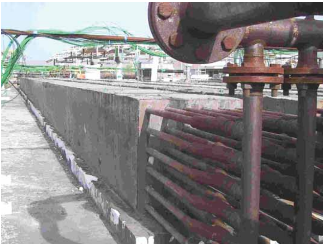
Abbildung 95: Speichermodul für WESPE-Projekt vor Anbringen der äußeren thermischen Isolation
