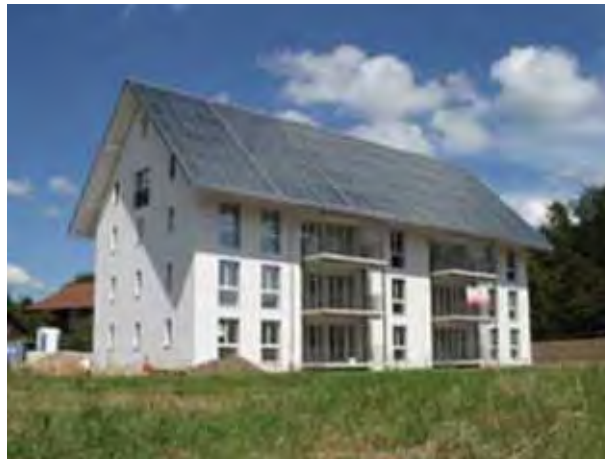
Abbildung 16: 100% solar beheiztes Mehrfamilienhaus in der Schweiz mit 193 kW th installierter Leistung und 205 m 3 Wärmespeicher
