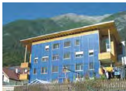
Abbildung 45: Farbige Absorberschichten als gestalterisches Element der Architektur (TISUN, Tirol)
