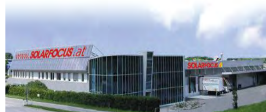
Abbildung 32: Der oberösterreichische Kollektorproduzent und Systemanbieter Solarfocus übersiedelte bereits im Jahr 2004 in das neue Werkgebäude in Steyr. Dort sind aktuell knapp 100 MitarbeiterInnen beschäftigt.
