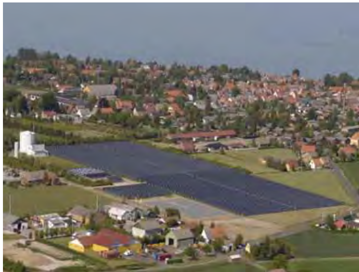
Abbildung 18: Die weltgrößte thermische Solaranlage in Marstal (DK) liefert mit einer installierten Leistung von 12,9 MW th 30% des Wärmebedarfs der Insel. (Quelle: Arcon, DK)
