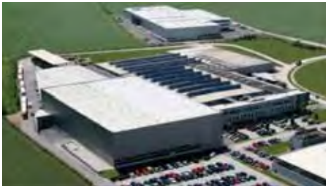
Abbildung 25: Der weltgrößte Flachkollektorhersteller GREENoneTEC erweiterte die Produktionsstätte 2007 um ein Hochregallager mit einem Fassungsvermögen für mehr als 100.000 m 2 Kollektorfläche. Aktuell sind über 400 MitarbeiterInnen am Standort St. Veit beschäftigt.
