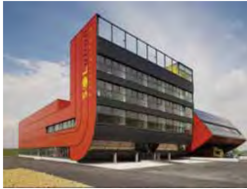
Abbildung 29: Rund 40 MitarbeiterInnen beschäftigt der oberösterreichische Systemanbieter und Großhändler SOLUTION Solartechnik im mit Mai 2008 bezogenen Headquarter in Sattledt
