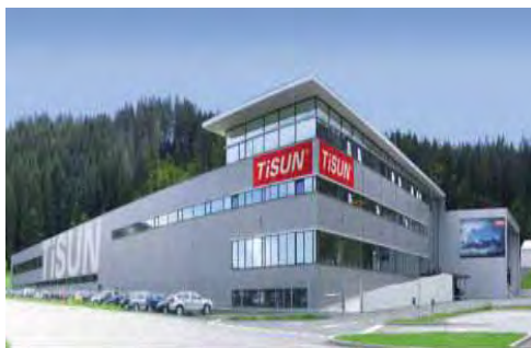
Abbildung 27: Der Kollektorproduzent und Systemanbieter TISUN errichtete 2007 eine neue Produktionsstätte im Tiroler Söll. An diesem Standort beschäftigt TISUN aktuell 120 MitarbeiterInnen, europaweit 225.
