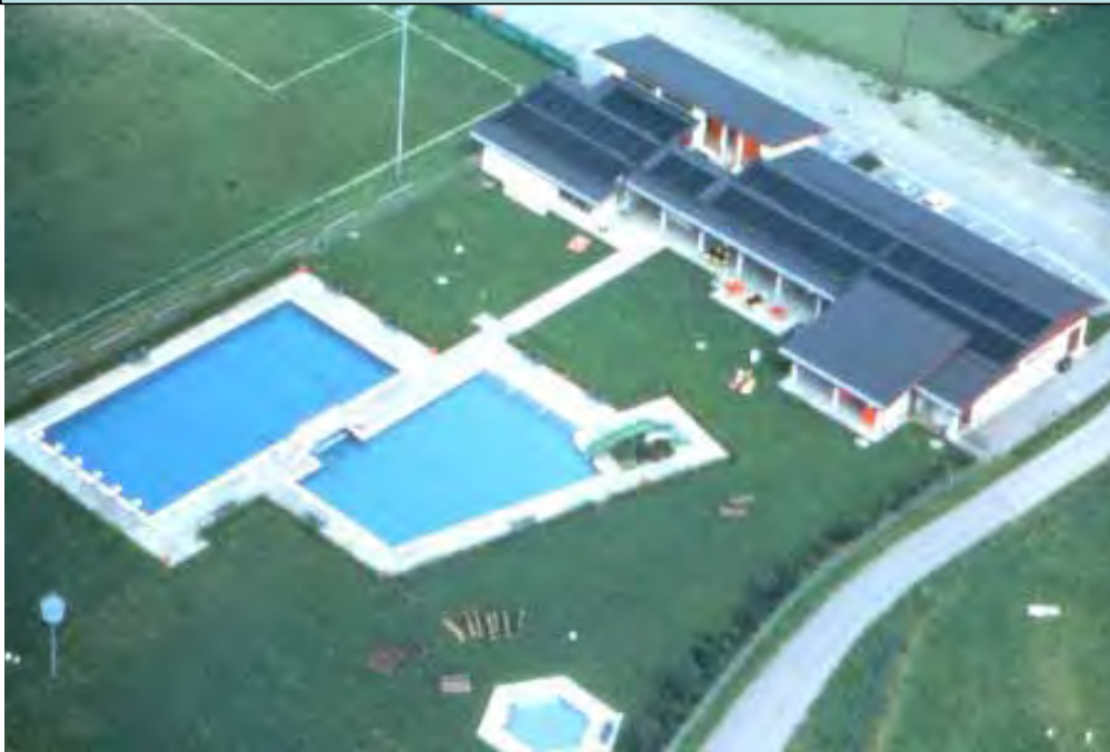
Bildtafel 3.7c: Solarthermische Anlagen Solaranlagen für Freibäder
