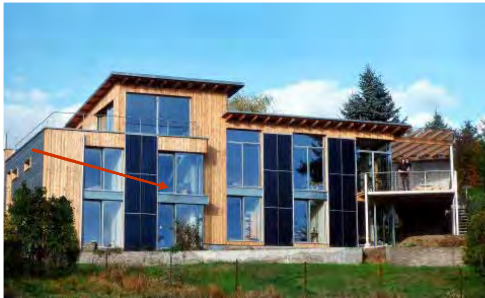
Bildtafel 3.7b: Solarthermische Anlagen Kollektor-Montage
