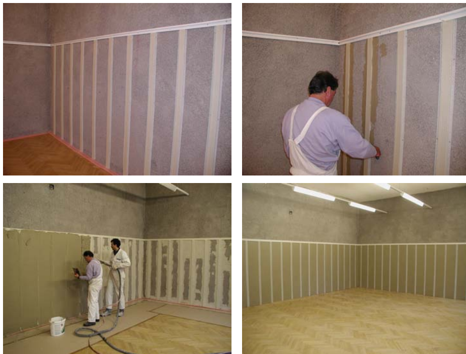
Fig. 23 Vor Ort Montage der Probe VII – Anheften, Fixieren und Verputzen der abgeklebten Aluminium-Lochblechprofile
