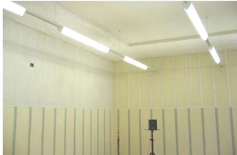
Fig. 54 Blick in die Klasse nach der Sanierung
