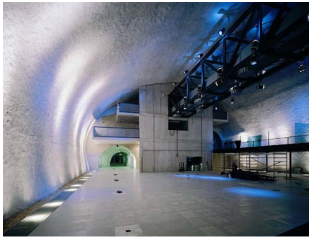
Fig. 2 Aufgespritzte Zelluloseakustikbeschichtung, Dom im Berg, Graz (Foto: Stadt Graz, Schmied)
