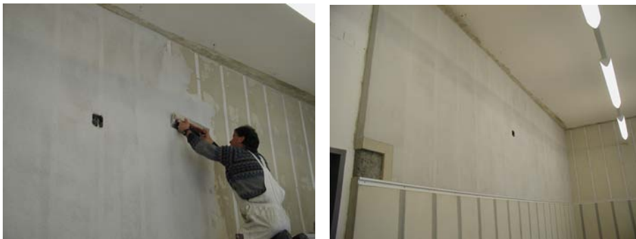
Fig. 25 Applikation des Einkornputzes auf Probe VI_mB
