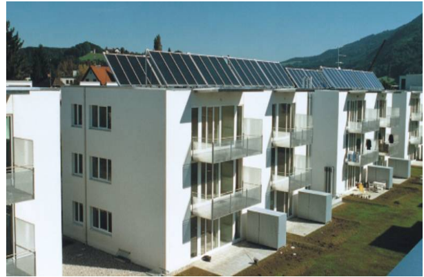
Abbildung 29: Südansicht des zentralen Gebäudes
