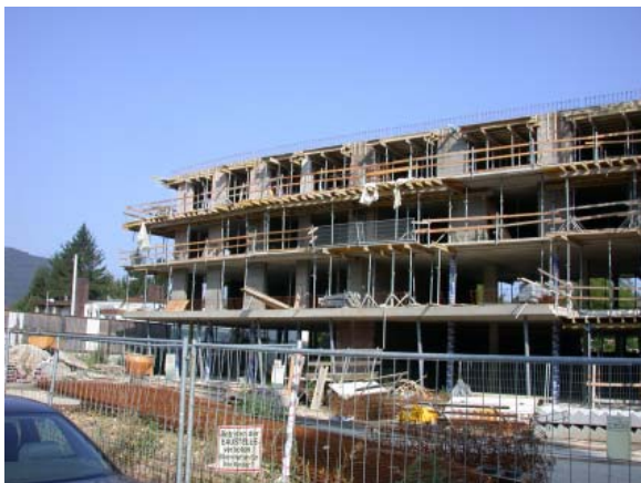
Abbildung 42: Ansicht des Demonstrationsobjekt während der Bauphase
