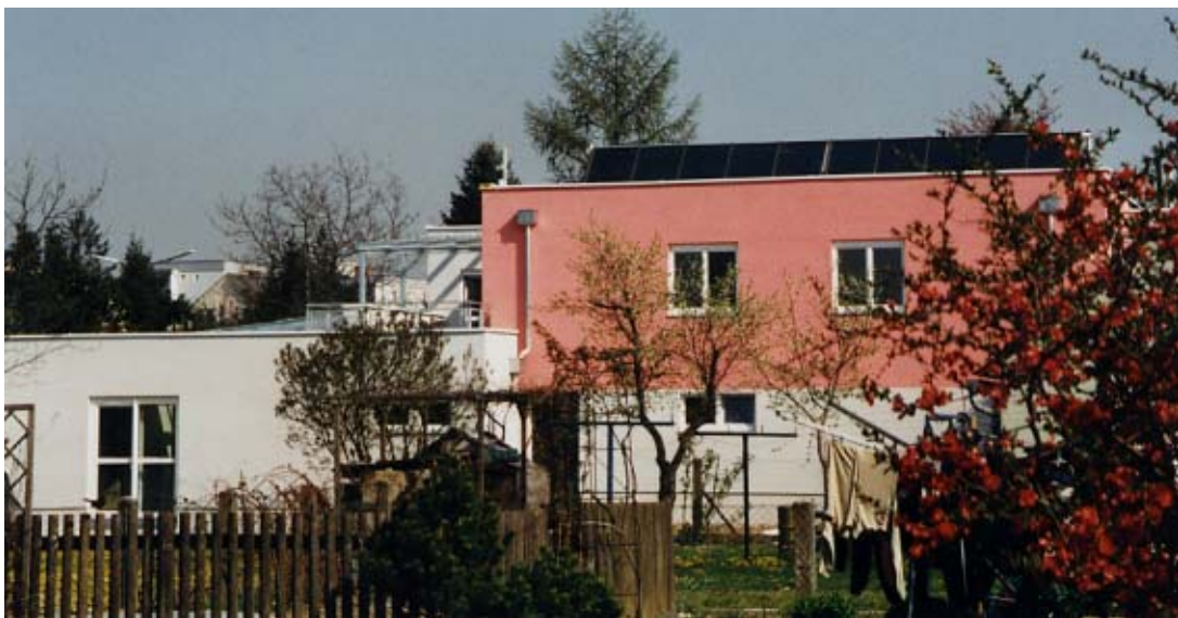
Abbildung 33: Südansicht des Demonstrationsobjektes „Nittnergasse“ nach Baufertigstellung
