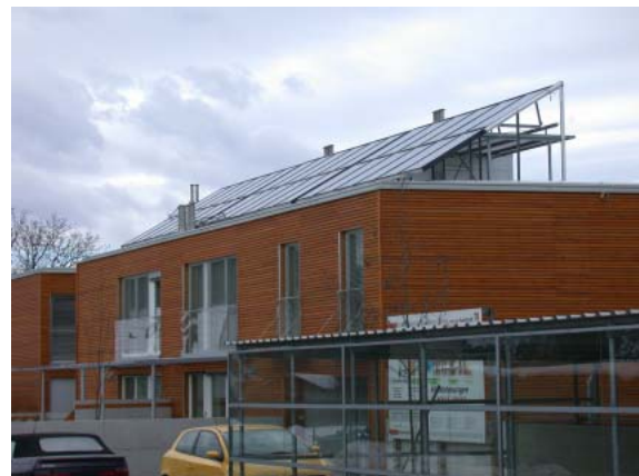
Abbildung 58: Ansicht der 88 m² großen Kollektorfläche am Demonstrationsobjekt „Schwarzer Weg“
