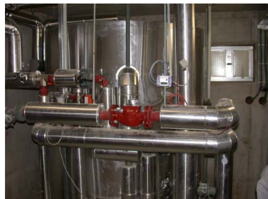
Abbildung 50: Bereits fertiggestellter Technikraum samt Speicher- und Rohrinsolierung
