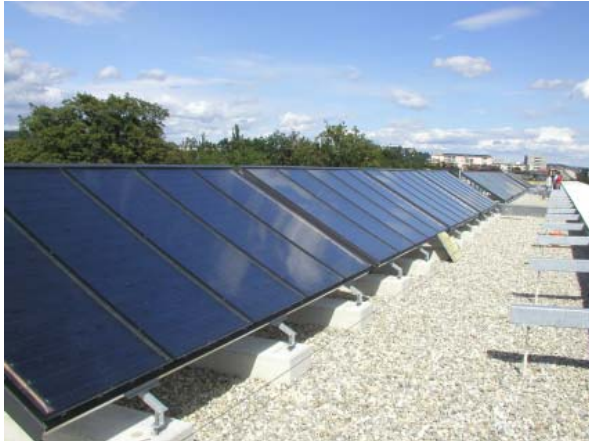
Abbildung 60: Ansicht der am Flachdach montierten 120 m 2 Kollektorfläche
