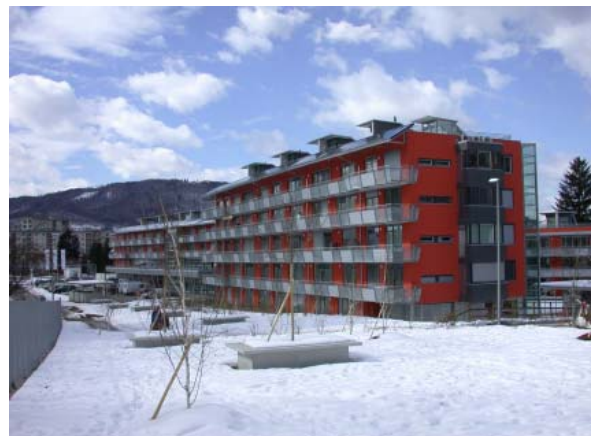
Abbildung 43: Ansicht des Demonstrationsobjekt nach Fertigstellung.
