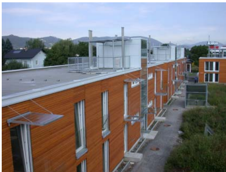
Abbildung 55: Ansicht des Demonstrationsobjektes „Schwarzer Weg“
