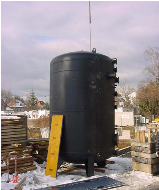
Abbildung 45: Lieferung des 20 m 3 fassenden Energiespeichers
