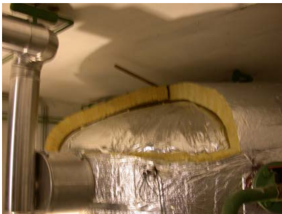
Abbildung 57: Ansicht des zentralen Energiespeichers während der Fertigstellung der Speicherdämmung
