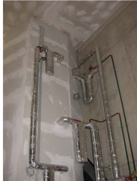
Abbildung 40: Mit 25 bis 35 cm starker Zelluloseeinblasdämmung isolierter Energiespeicher
