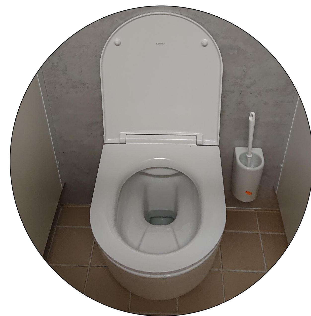
Neu installierte Trenntoilette am Standort Gmunden der Fa. Laufen.
