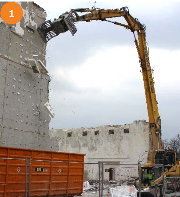
1 Rückbau von EPS-Wärmedämmverbundsystemen (WDVS)
