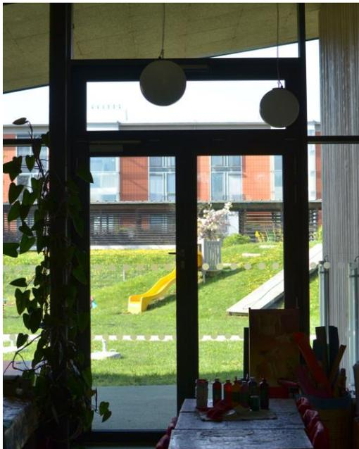
Abbildung 2-6: Innenansicht Notausgang mit Kippflügel
