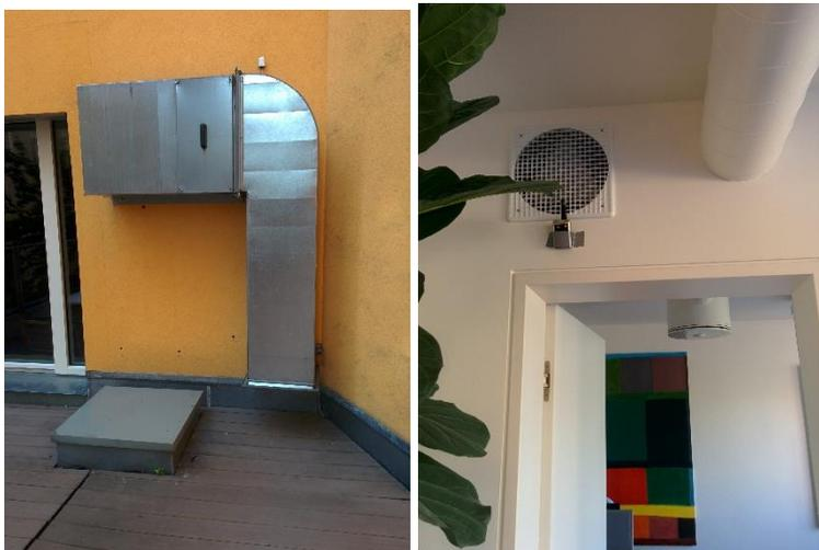
Abbildung 2-14: Komponenten der Nachtlüftung (v.l.n.r.): AUL-Ansaugung, ZUL-Gitter
