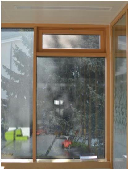
**Abbildung 2-4: Innenansicht Fixverglasung mit Kippflügel**
