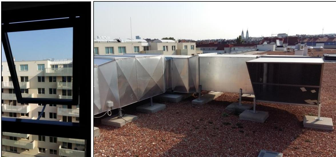
Abbildung 2-8: Komponenten der Nachtlüftung (v.l.n.r.): ZUL-Fenster, ABL-Anlage mit FOL-Gitter
