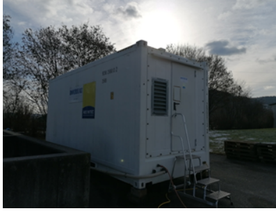
Abbildung 2: Eine in einem Container installierte Membrandestillationsanlage wurde für einen zweimonatigen Realbetrieb an der Abwasserreinigungsanlage Gleisdorf installiert (V.l.n.r: Containeranlage von außen, Container von innen, Membrandestillationsmodul), (Quelle: AEE INTEC)
