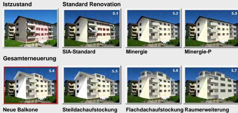
5.4 Gesamtheitliche Erneuerung der Gebäudehülle in Minergie-P-Standard mit Renovationsmodulen: Verputzte oder hinterlüftete Aussendämmung 250mm mit integrierter Lüftung, Fensterersatz U=0.7 W/m²K, Dämmung des Dachbodens und der Kellerdecke, Erneuern der Balkone, Einbau einer kontrollierten Lüftung, Innenrenovation
