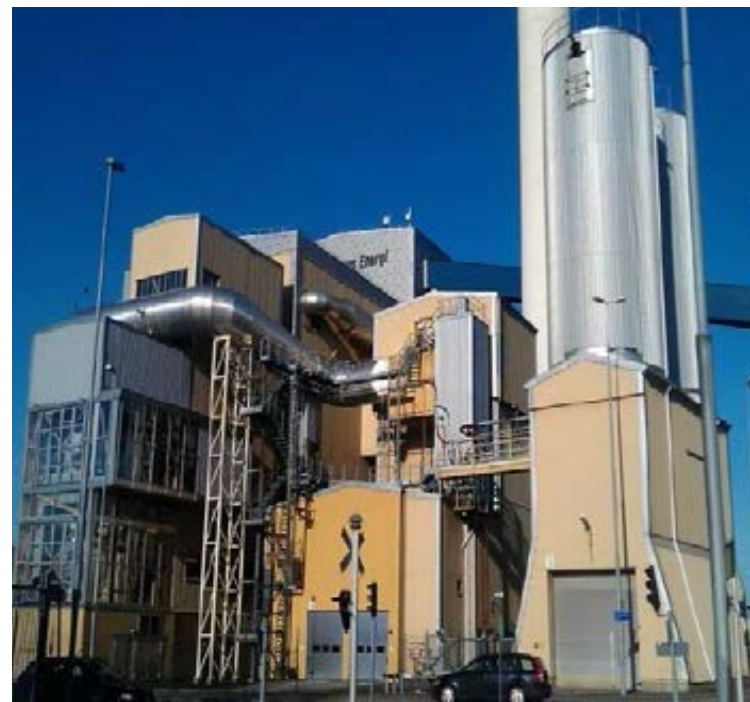
Göteborg Energi 130MW (BFB)
