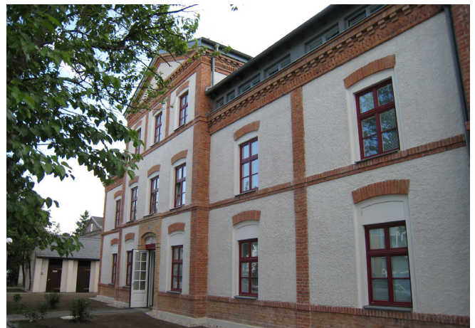
Arbeiterwohnanlage Felixdorf nach der Sanierung © Florian Mayer
