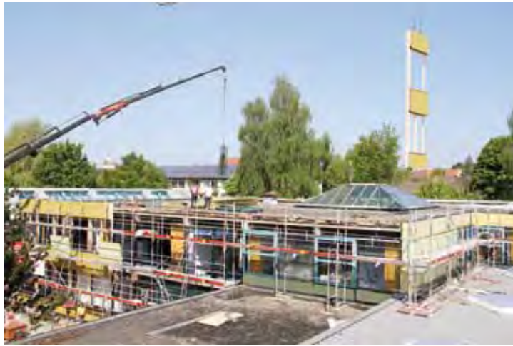
Peter-Schweizer-Schule Gundelfingen, Vorfertigung und Montage der Holztafelelemente. Planung: lattkearchitekten. Vorfertigung: Gump & Maier, Binswangen. Fotos: Frank Lattke (1), Stefan Thessenwitz (2)
