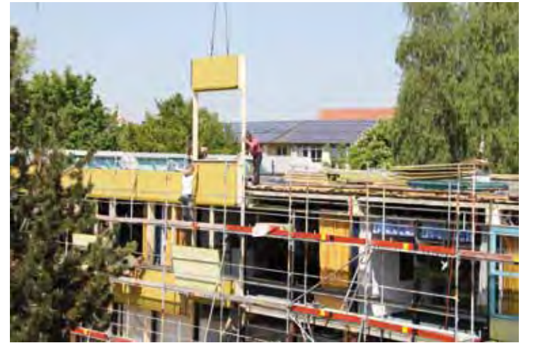
Peter-Schweizer-Schule Gundelfingen, Vorfertigung und Montage der Holztafelelemente. Planung: lattkearchitekten. Vorfertigung: Gump & Maier, Binswangen. Fotos: Frank Lattke (1), Stefan Thessenwitz (2)
