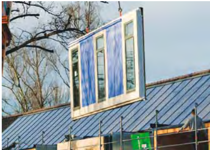
Bad Aibling, Umbau und Modernisierung ehemaliger Militärbauten zu modernen Wohn-, Gewerbe- und Dienstleistungsgebäuden. Bestandsgebäude, Montage der Holztafelelemente mit integrierter Flächenheizung und Fassade nach der Modernisierung. Fotos: RK-Stuttgart Architekten, Schankula Architekten
