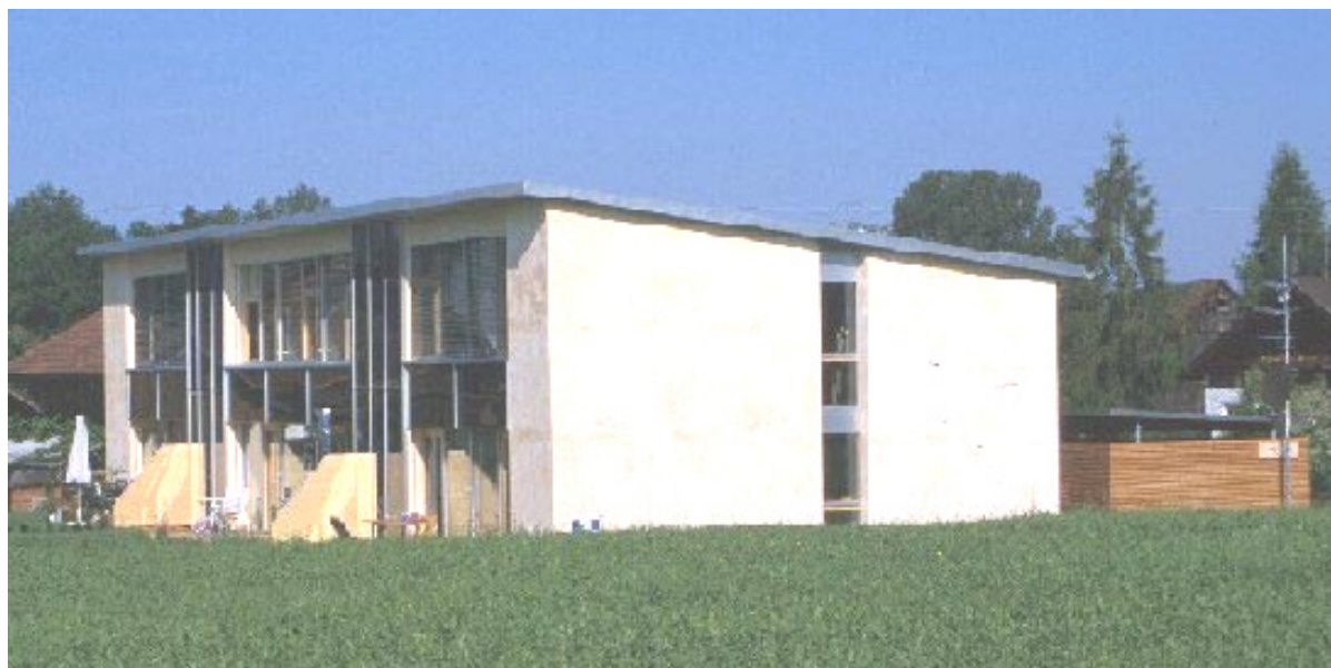
Abbildung 21: Reihenhaus in Hörbranz, Quelle: KRAPMEIER, Energieinstitut Vorarlberg, Architekt: Richard Caldonazzi, Frastanz, Bezugsfertig: Juli 1999
