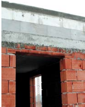
Abb. 7: Attikaausführung mit Gasbetonsteinen. Fotos Wilhelm Hofbauer (7)
