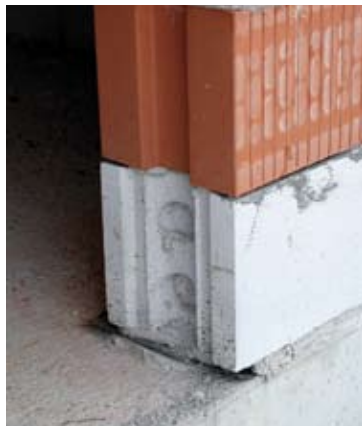
Abb. 11: Gasbetonsockel beim Ziegelmauerwerk
