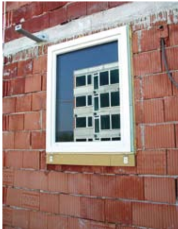
Abb. 6: Einbau der Passivhausfenster und thermische Trennung der Vordachverankerung
