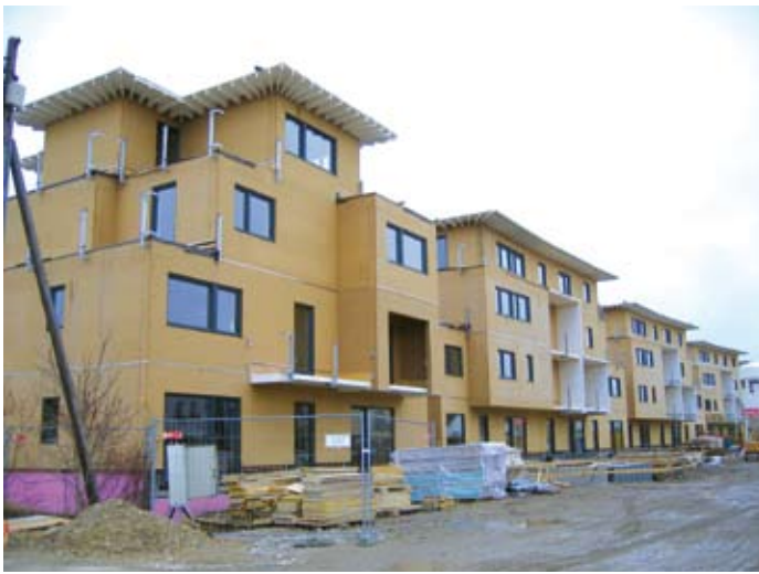
Abb. 12: Klima.Komfort.Haus: Rohbauten. Foto: Haselsteiner
