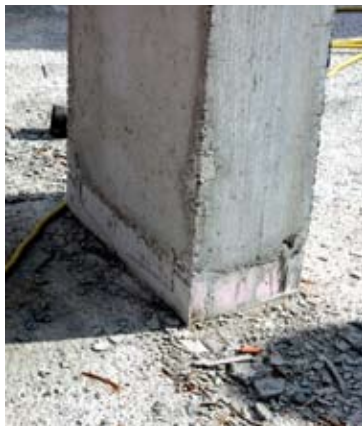
Abb. 10: Fußpunkt Stahlbetonpfeiler mit Isokorb und Wärmedämmung
