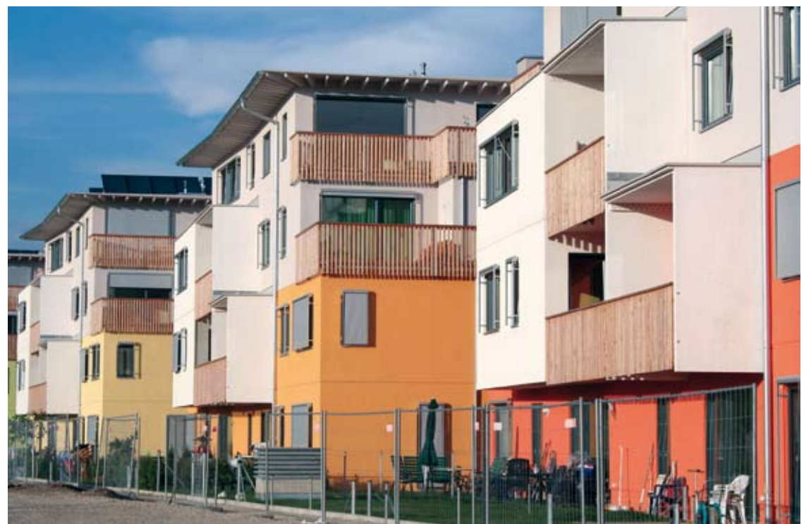
Abb. 2: Klima.Komfort.Haus. Architekt Werner Hackermüller. Foto: Mantler-Reprou
