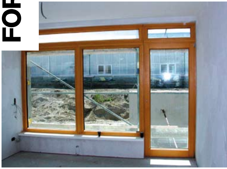
Abb. 4: solarCity Linz: Verglasung mit TWD Element
