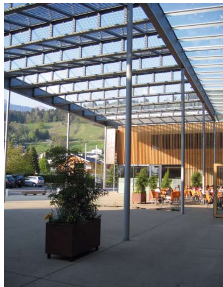
Abb. 13: Transluzente Fotovoltaikanlage, überdachter Dorfplatz. Foto: Edeltraud Haselsteiner
