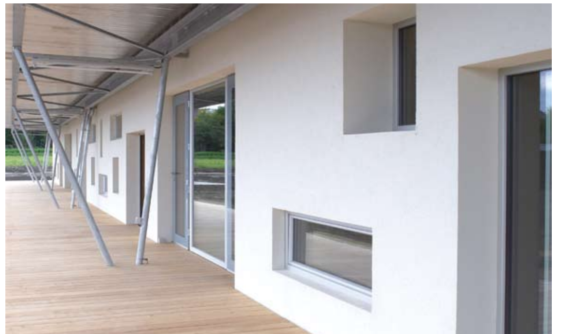
Abb. 1: Passivhauskindergarten Ziersdorf; AH3, Architekt: Johannes Kislinger. Foto: Dieter Schewig (www.schewig-fotodesign.at)
