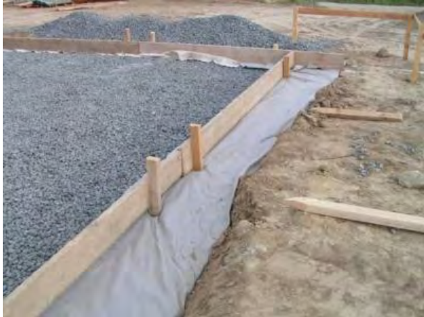
Abbildung 2: Glasschaumgranulatschicht vor dem Betonieren der Bodenplatte
