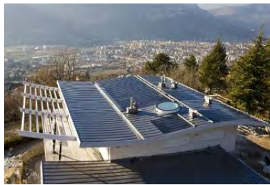
aSi PV- Module © Architekten Informations System, www.ais-online.de
