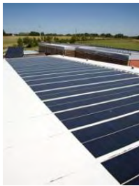
aSi PV- Module © Architekten Informations System, www.ais-online.de
