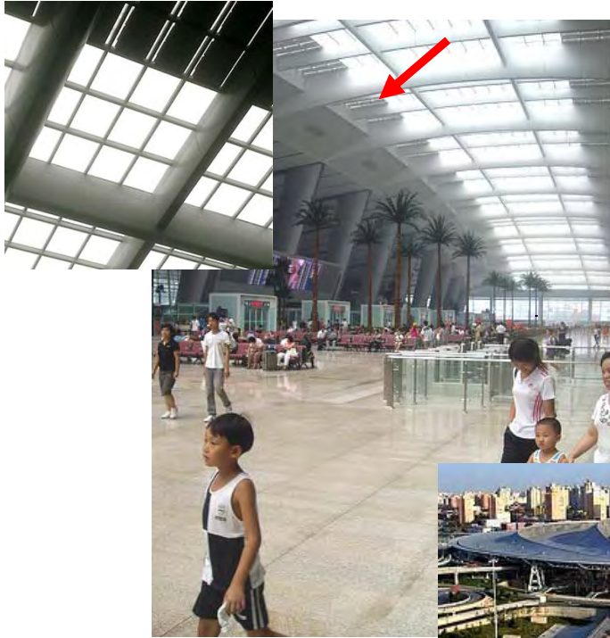
Bahnhof Peking 2008 5.200 PV-Module (CIS)
