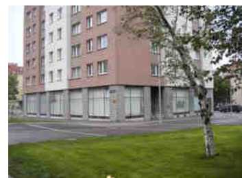
(17) Platz beim Hochhaus mit ungenutzten Erdgeschoss
