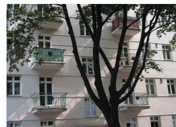
(7), (8), (9) Engelsplatzhof Architekt Rudolf Perco verschiedene Balkontypologien von oben nach unten: Laubengang massive seitliche Brüstung offenes Geländer
