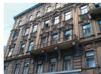
(4) Gründerzeitgebäude, Balkon ist Teil des Fassadenschemas
