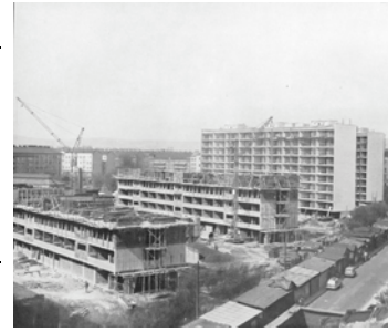
(36) Errichtung der Anlage
