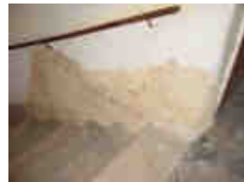
(1) Sockelsanierung Blocksonderförderung Wien 15, Reithofferplatz
