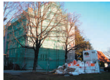
(1) Thermische Gebäudesanierung in Wien
