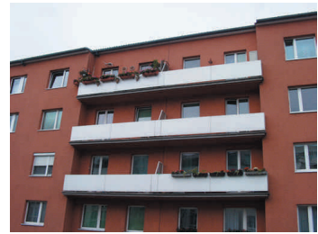
(8) Balkone teilweise eingebaut, Reihe
