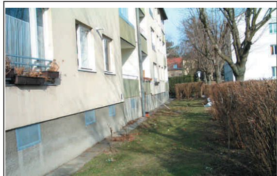
Halbgeschosse des Bestandes ohne Zugang in den Freiraum
