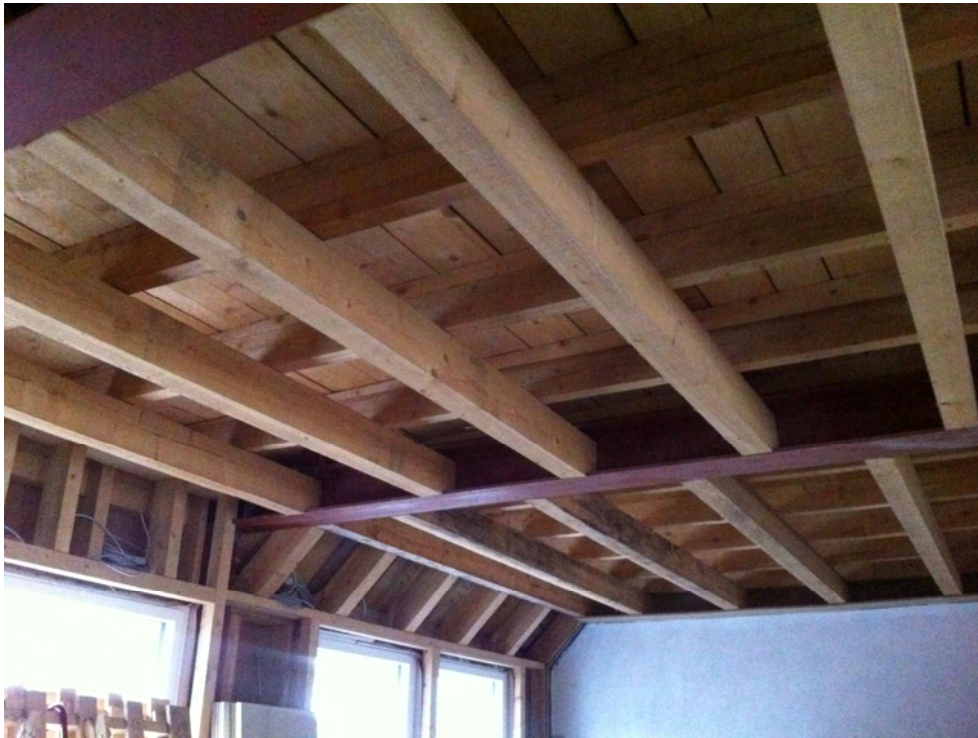
Abbildung 19: doppelschalige Holzkonstruktion zwischen Stahlträgern [Schöberl & Pöll GmbH]
