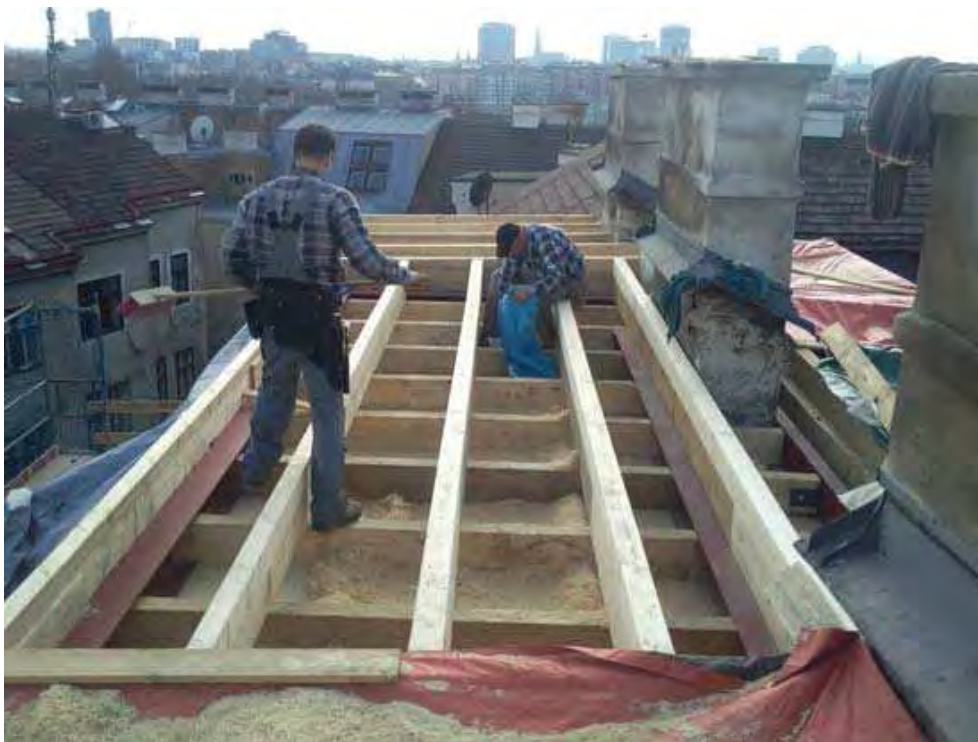
Abbildung 23: Verlegung der Keilpfosten [ZIL10]
