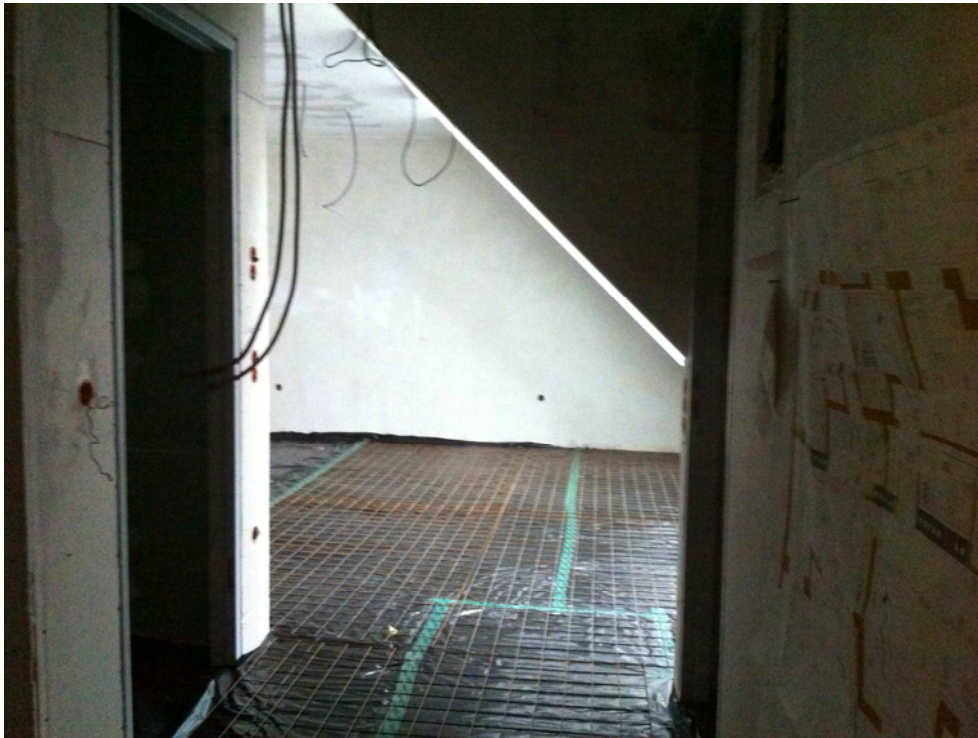
Abbildung 37: Herstellung des schwimmenden Estrichs im Hoftrakt [Schöberl & Pöll GmbH]
