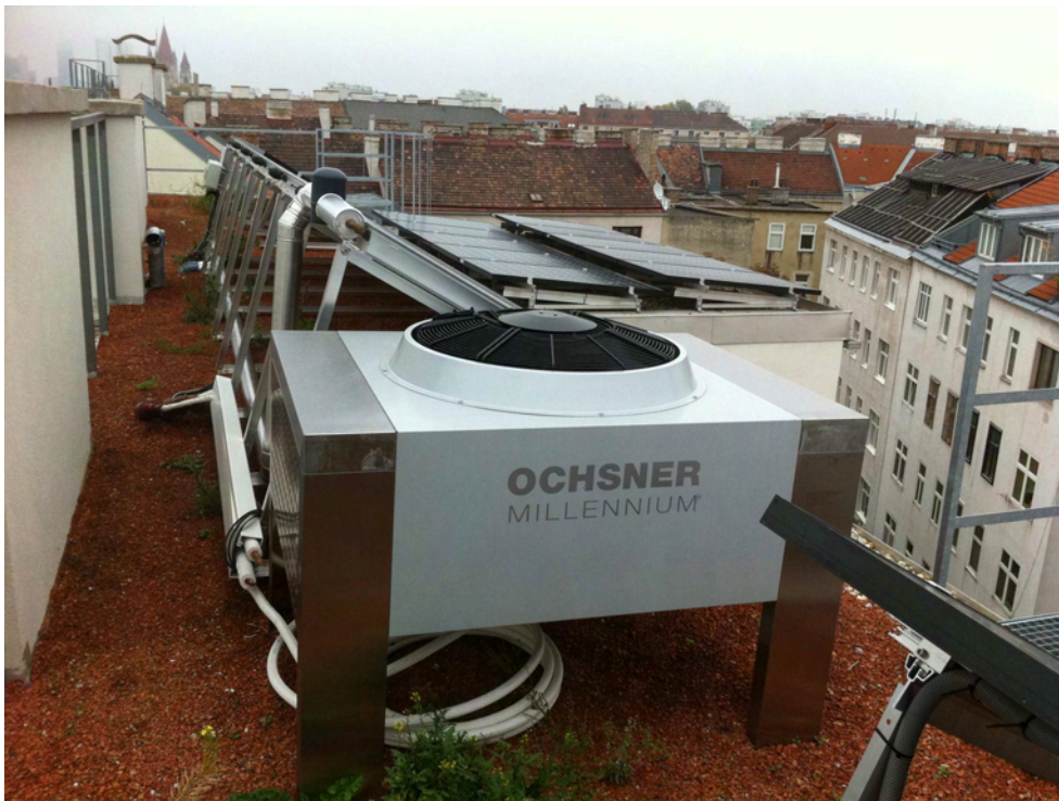
Abbildung 31: Luft-Wasser-Wärmepumpe [Schöberl & Pöll GmbH]
