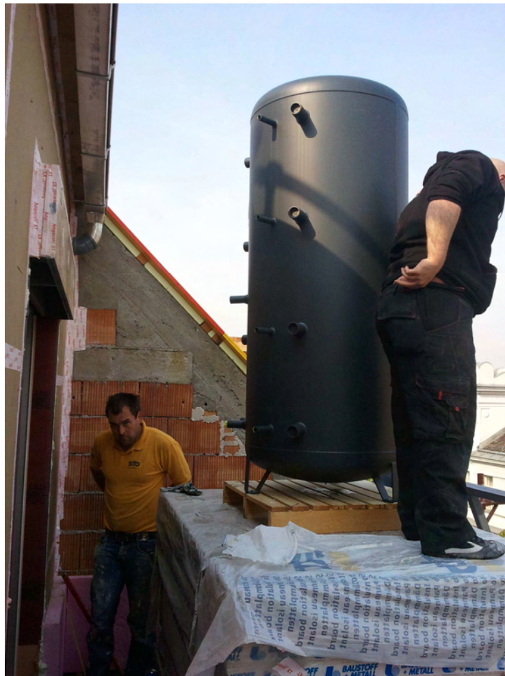
Abbildung 30: Lieferung des Pufferspeichers [Schöberl & Pöll GmbH]
