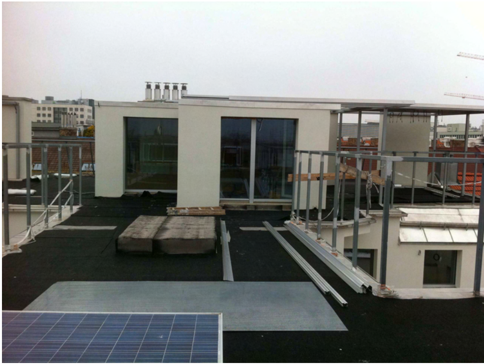
Abbildung 33: Ausstieg auf die Dachterrasse [Schöberl & Pöll GmbH]
