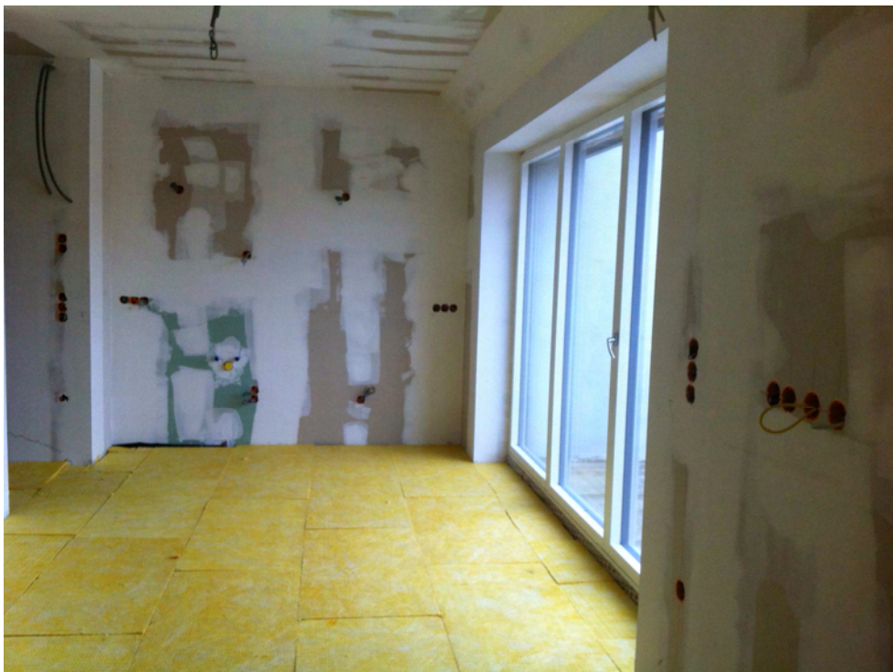
Abbildung 36: Verlegung der Trittschalldämmung im Hoftrakt [Schöberl & Pöll GmbH]
