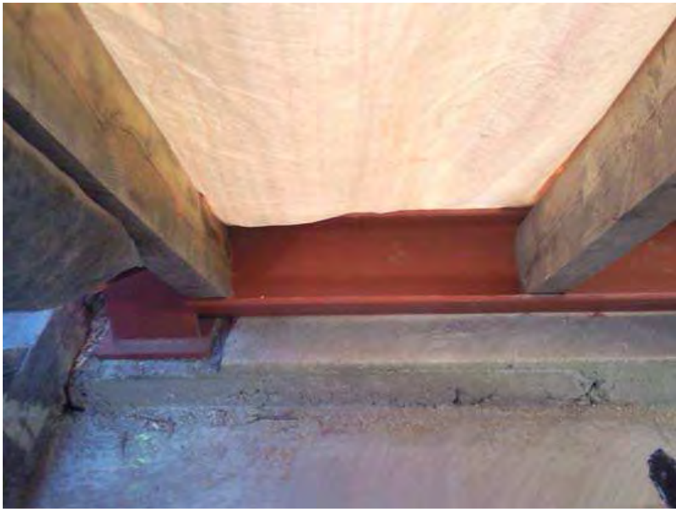
Abbildung 15: Anschluss der Stahlrahmenkonstruktion im Kniestockbereich [ZIL10]
