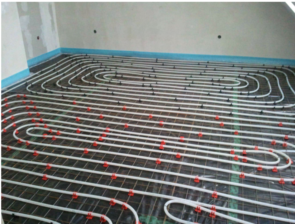
Abbildung 38: Verlegung der Schläuche für die Bauteilaktivierung im Hoftrakt [Schöberl & Pöll GmbH]
