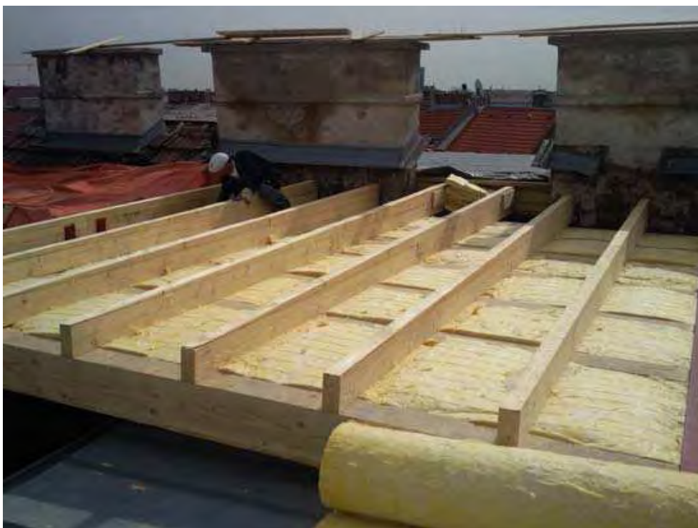
Abbildung 24: Verlegung der Dämmung in den Zwischenräumen der Holzkonstruktion [ZIL10]
