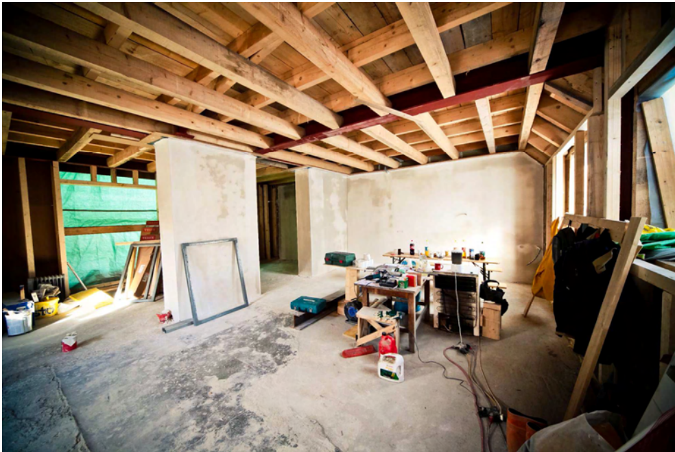
Abbildung 16: tragende Stahl-Holzkonstruktion [Schöberl & Pöll GmbH]
