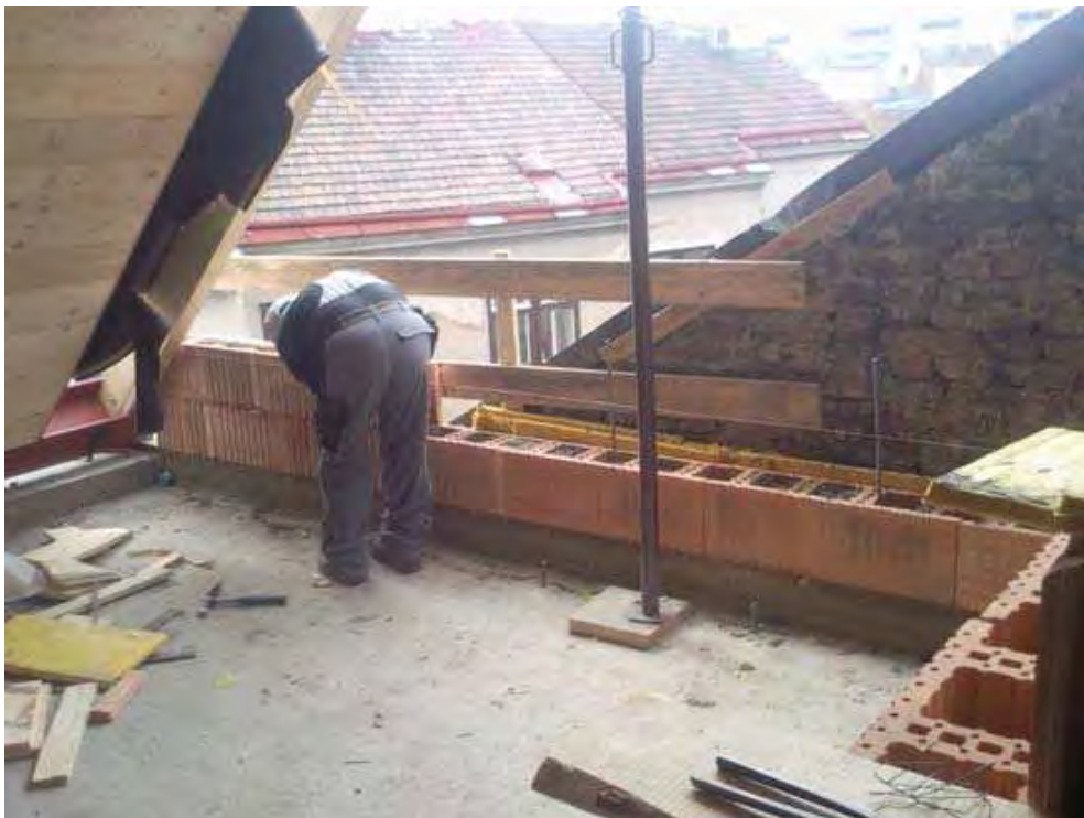
Abbildung 22: Herstellung der Feuermauer [ZIL10]
