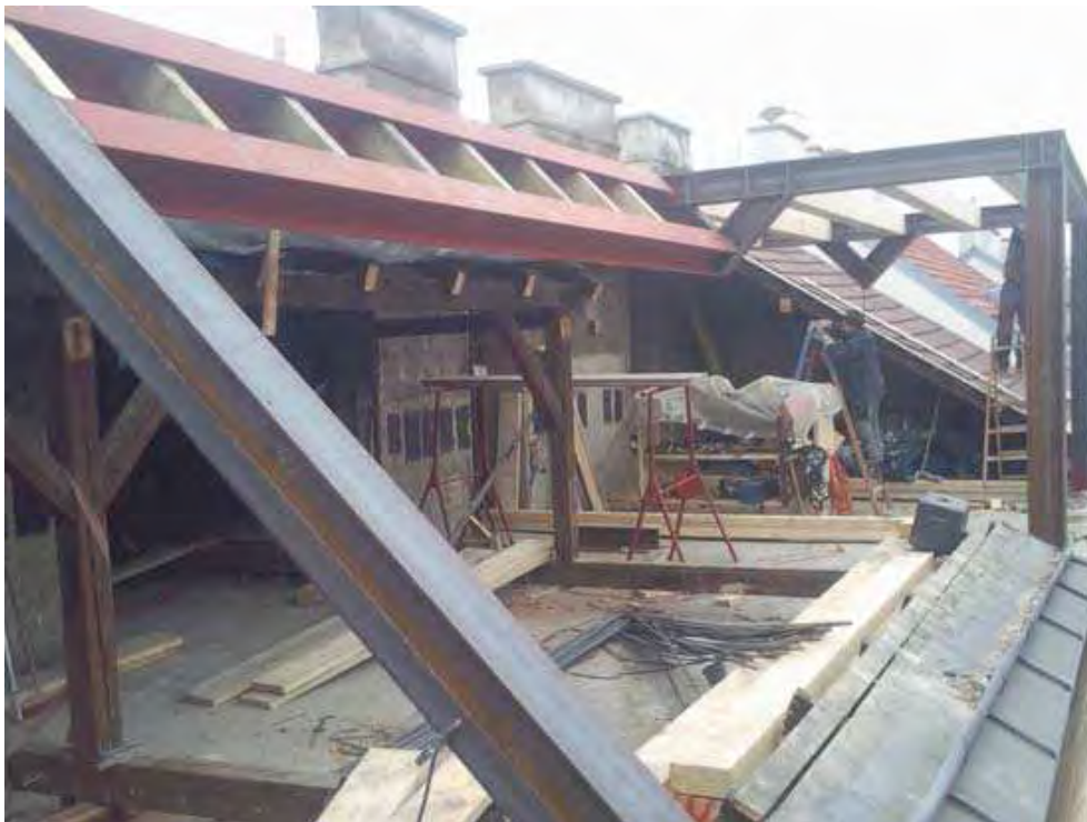
Abbildung 14: Stahlrahmenkonstruktion des Dachstuhls [ZIL10]
