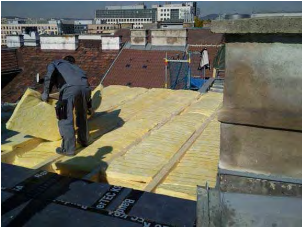
Abbildung 25: Verlegung der Dämmung zwischen den Keilpfosten [ZIL10]
