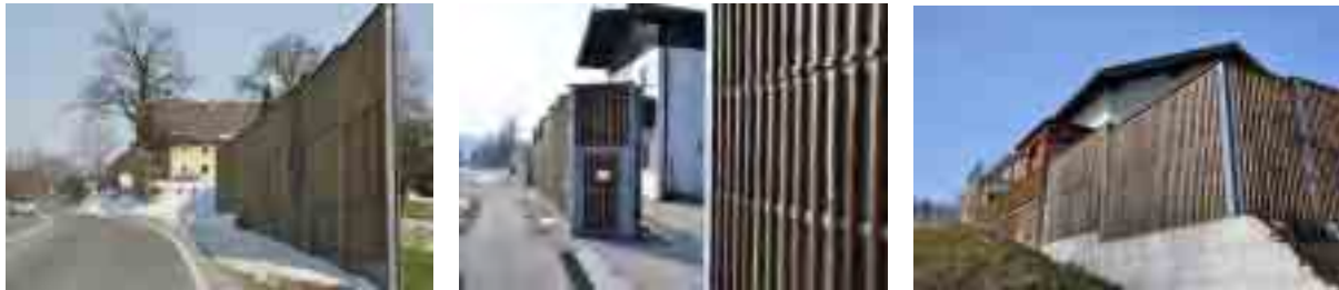
Zu hinterfragende, nicht durchgängige Lärmschutzwand an der Linzer Bundesstraße (B1)
