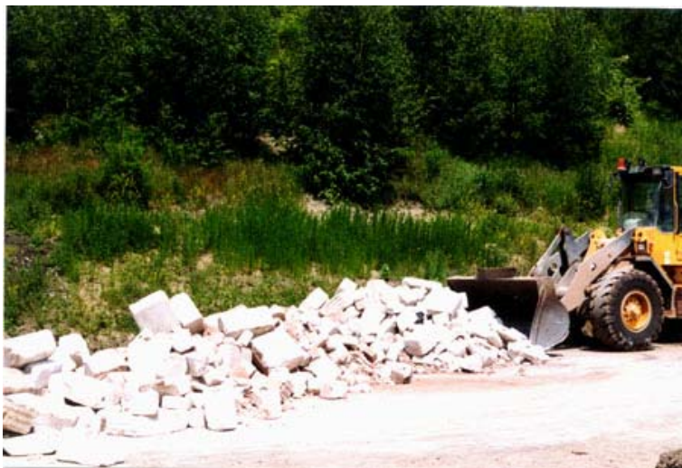
Abbildung 57: Verladung des Kalksandstein-Bruchmaterials mit dem Radlader
