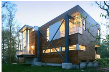
Abbildung 12: Big Dig House
