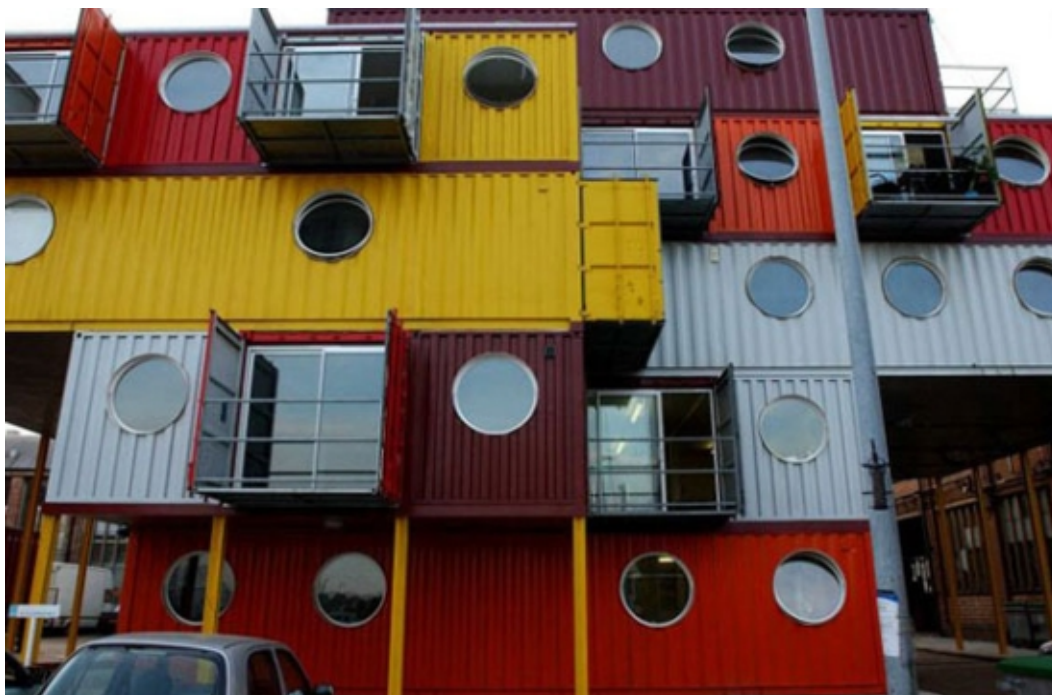
Abbildung 36: „Container City“, 2002, London/ Urban Space Management Ltd.
