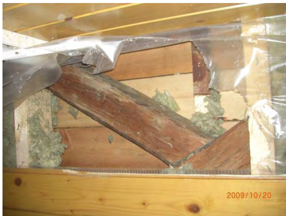
Abbildung 7a: Holzriegelwand im nicht geöffneten Zustand
