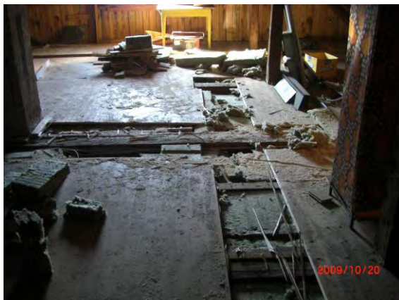
Abbildung 6a: Decke zwischen 1. OG und DG (Detail)
