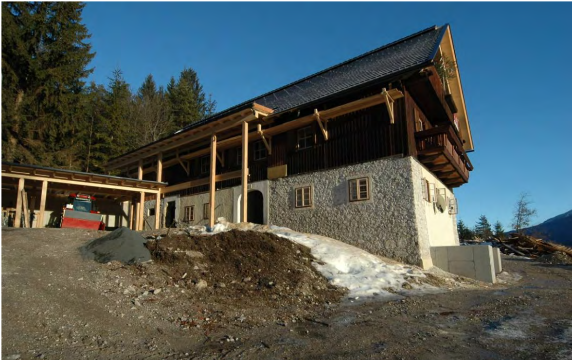
Abbildung 18: Südwest-Ansicht mit Carport und neuem Dachstuhl
