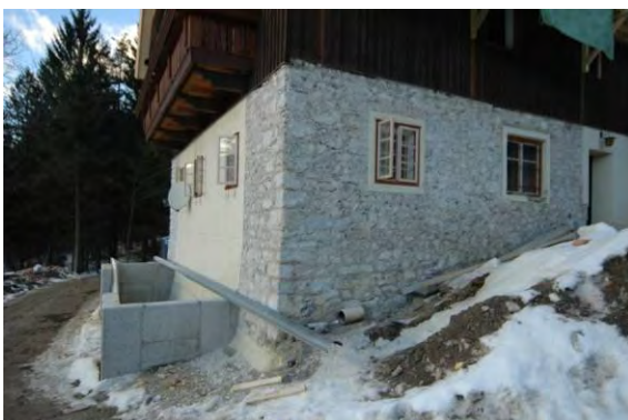
Abbild. 18c: Steinmauerwerk Südostansicht
