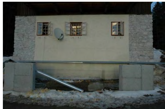
Abbild. 18b Südansicht (die Putzfläche wird aufgestellt)
