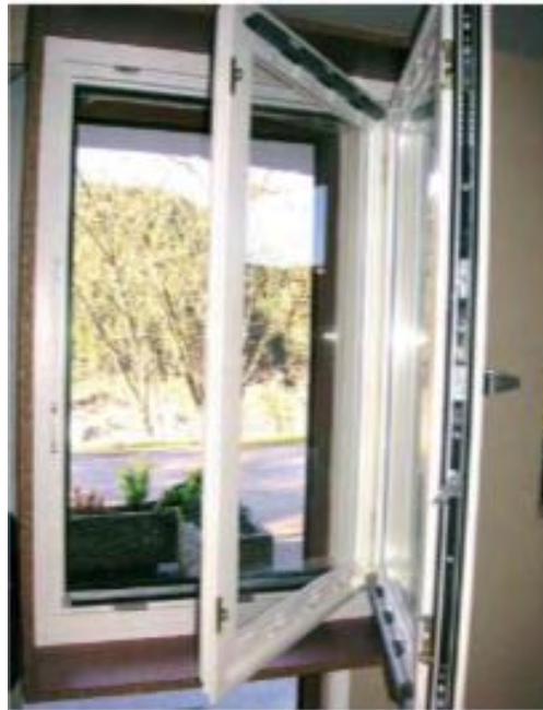
Abbildung 21: Prototyp der Klima-Verbundfenster-Technologie; Quelle: ISY Innovation GmbH (2010)
