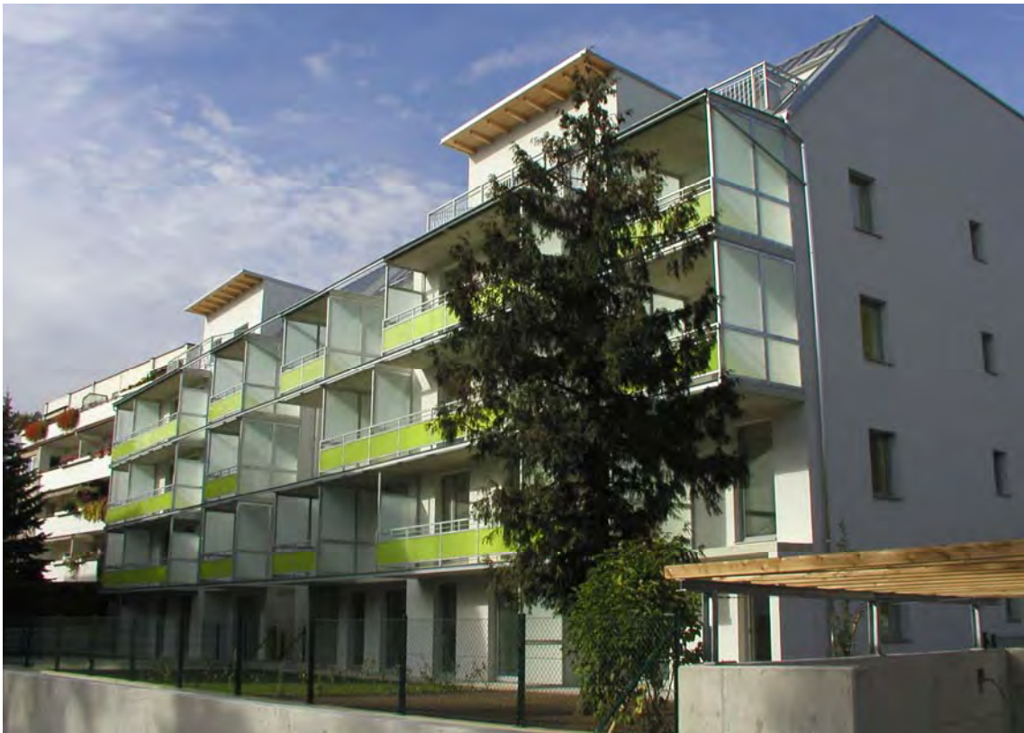
Abbildung 4: Passivhauswohngebäude Utendorfgasse [AEE INTEC]
