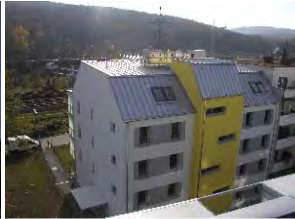
Dachansicht der fertigen Anlage Quelle: AEE INTEC
