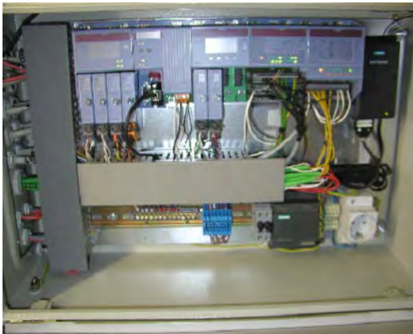
Abbildung 18: Eingebautes Loggersystem
