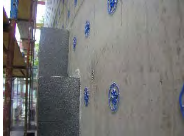
Aufbringen der Außenwandwärmemedämmung
