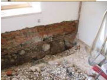
Erstellen einer Nische für Mauerbündige Innendämmung
