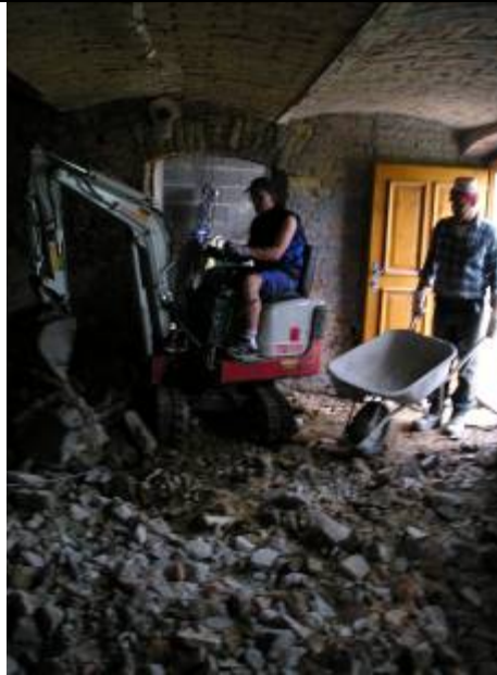
Abbruch des Stallbodens
