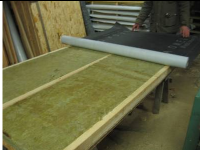
Bild 1 Fertigen des Grundelementes mit Wärmedämmung und Windbremse
