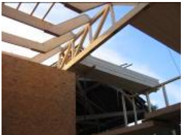
Montage des Zubaues
