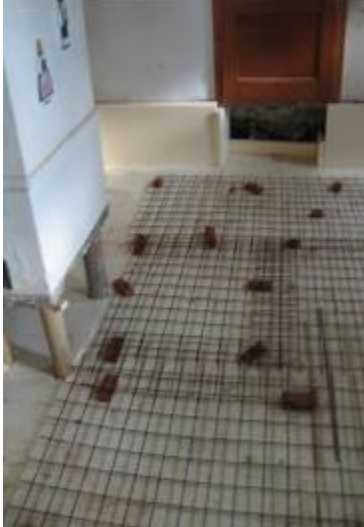
Abbruch des bestehenden Fußbodens in der Stube, Einbringen der thermischen Trennung mit Unterfangung des bestehenden Kachelofens
