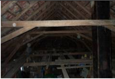
Altbestand der Dachkonstruktion
