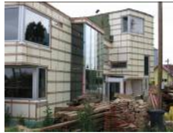
Wandbereiche mit Klemmleisten, Styroporplatten als Schutzdämmung und Lattung für die Fassadenverkleidung
