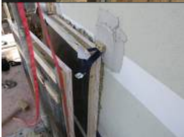
Montage der 2-Mannplatte mit Hilfe einer Seilwinde
