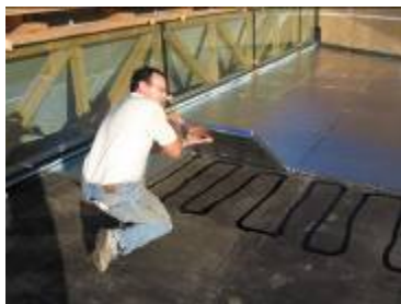
Abbildung 14: VIP-Verlegung Flachdach
