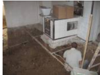
Abbruch des bestehenden Küchenbodens mit Unterfangung des Tischherdes
