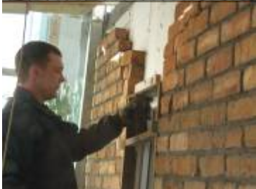
Erstellen des 2-schaligen Sichtmauerwerkes
