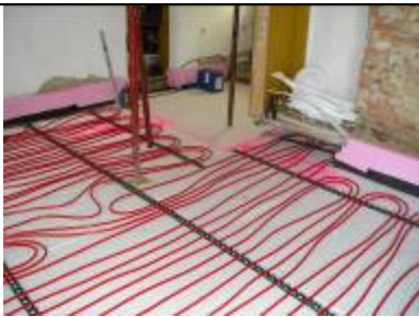
Einbringen des neuen Bodenauf- baues mit Fußboden- heizung
