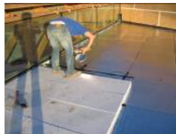
Streifenförmiges Aufbringen des Klebers auf den Vakuumpaneeelen und Verlegen der EPS-Dämmung
