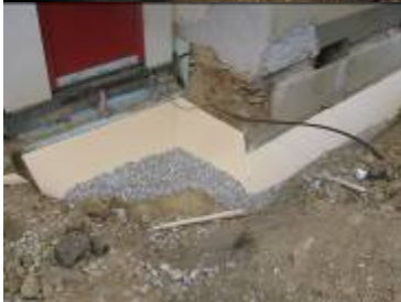
Abbildung 43: Arbeitsablauf Sockeldämmung
