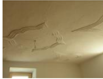
Restaurierung des Deckenstucke im ehemalige Wohnzimmer
