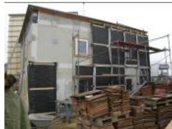
Montierte Holzwandelemente an an der Ostseite
