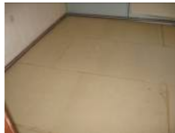
Verlegen des schwimmenden Estriches
