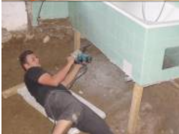
Abbruch des bestehende Bades unter Erhalt der eingemauerten Badewanne
