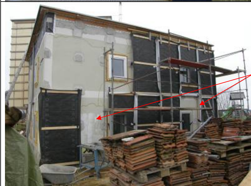
Abbildung 25: Fertigung "2-Mann-Platte"
