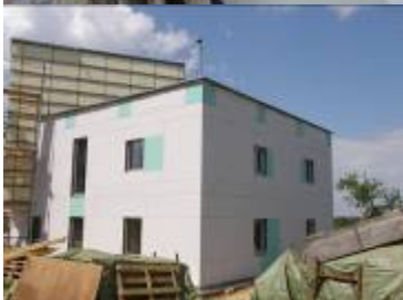
Altbau mit fertig gestellter OSB-Plattenfassade
