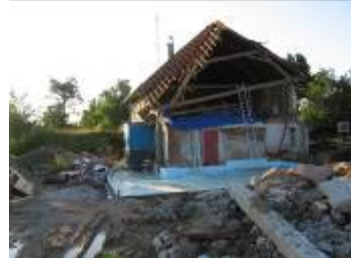
Errichtung der Fundamentplatte für den Neubau
