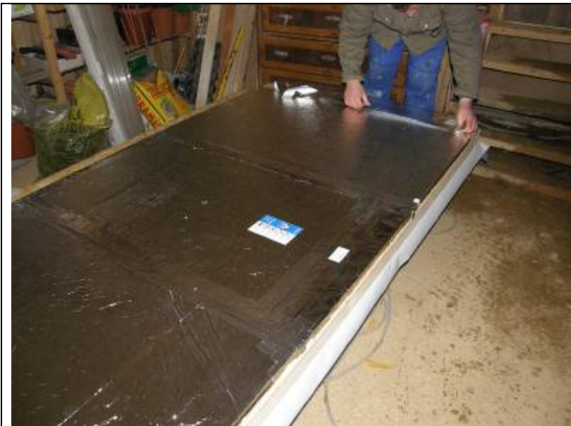
Bild 3 Abkleben der Fugen
