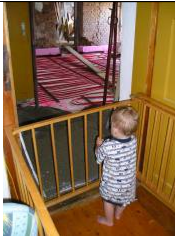
Einbringen des neuen Bodenauf- baues mit Fußboden- heizung
