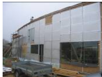
Montage der Vakuumdämmung – Klemmleistentchnik
