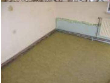
Verlegen der Trittschall-dämmplatten
