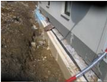
Perimeterdämmung im Bereich des Altbaues
