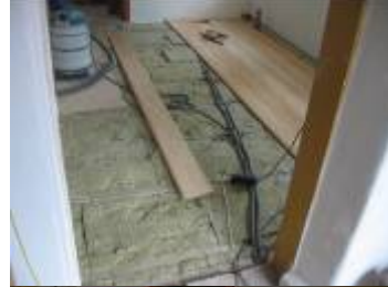
Verlegen des Lärchenschiffbodens auf Polsterhölzer
