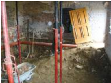
Abbruch der tragen- den Zwi- schenwand
