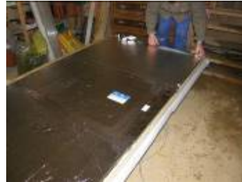
Erstellen der 2-Mannplatte
