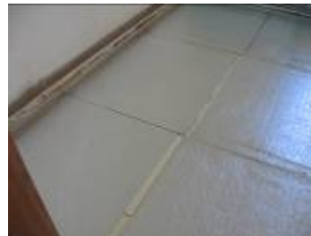
Verlegen der Vakuumdämmung im Bereich des ehemaligen Wohnzimmers. Hier tauchte überraschenderweise ein Unterbeton auf.
