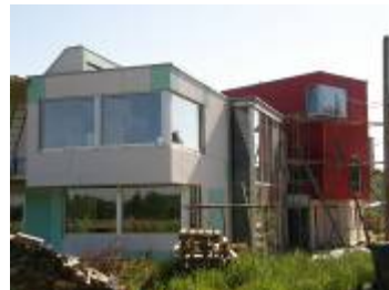
Zubau und Turm mit fertig gestellter Fassade
