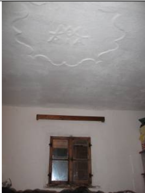
Deckenstück mit historischem Fenster
