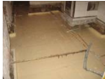
Einbringen der thermischen Bodentrennung im Badbereich
