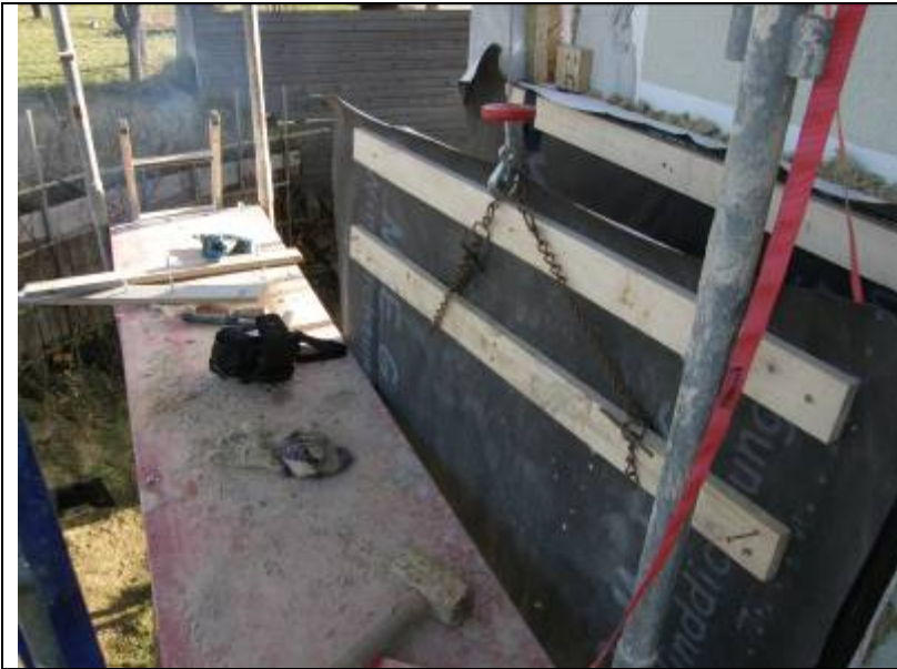
Bild 6 Montage der Elemente mittels Flaschenzug
