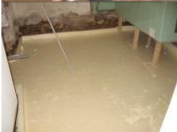
Einbringen der thermischen Bodentrennung im Badbereich
