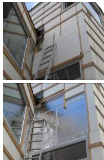
Demontage der Lattung
