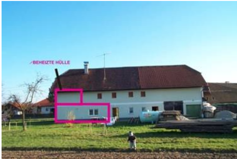
Abbildung 7: Beheizte Hülle Nordansicht mit Gastank
