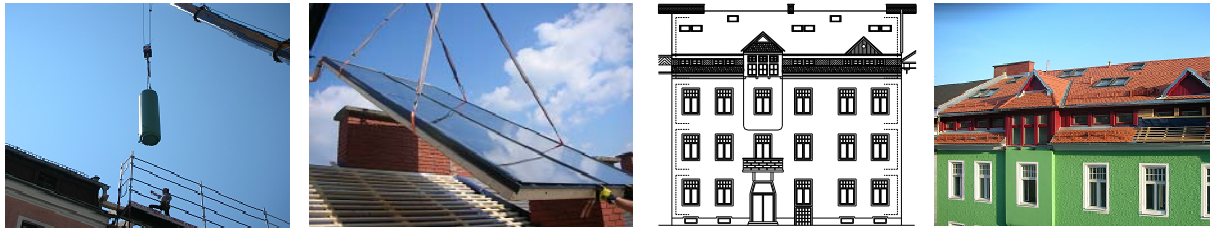
Bild: Einbau des Solarspeichers und des Kollektors, Ansicht (Planmaterial)) vor und nach der Sanierung
